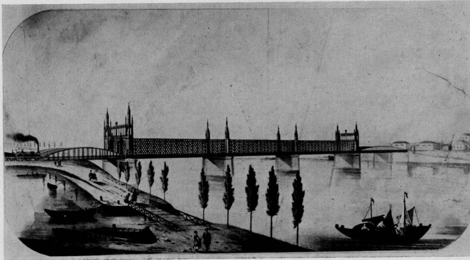
Die erste Eisenbahnbrücke (von 1861 bis 1944) auf vier Steinfeilern mit zierlicher Eisengitterkonstruktion und schlanken Türmchen; die Anschlußstücke zu den beiden Ufern sind die Drehbrücken. Rechts die Kehler Seite.
