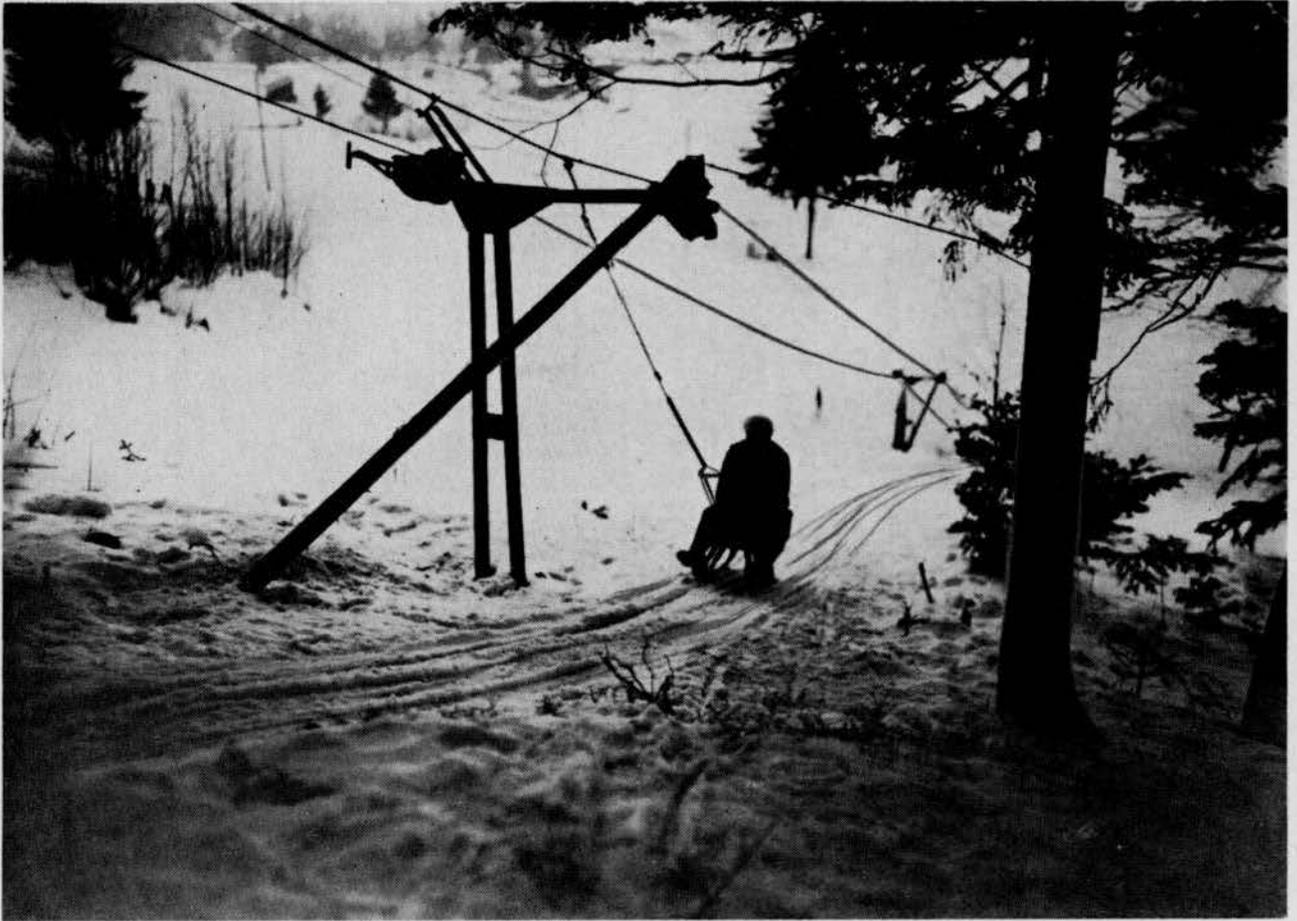
So zog der Lift die Spezial-Liftschlitten bergauf im Gelände bei der Sprungschanze.
