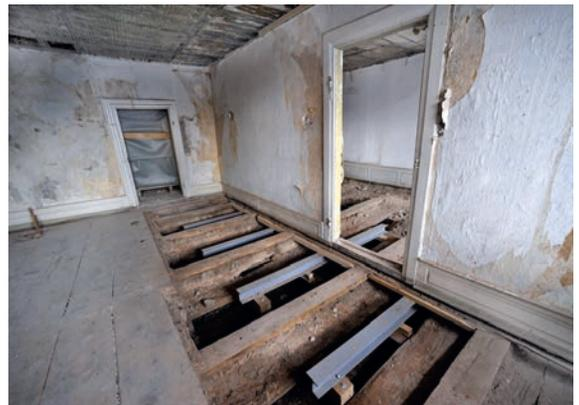
Abb. 8: Verstärkung der Böden durch Stahlträger.
