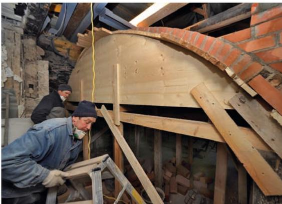
Abb. 15: Restaurierung und Nachbau des Gewölbes.
