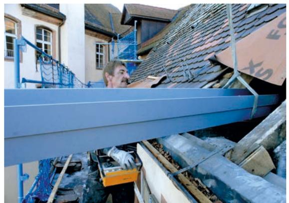
Abb. 9: Einbringen der Stahlträger über den Dachstuhl.
