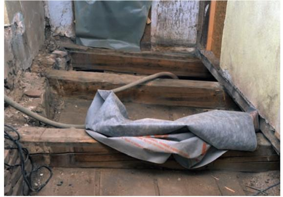
Abb. 12: Flurbereich im 2. Obergeschoss: Entkernung des Fußbodens.
