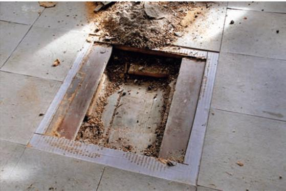
Abb. 11: Raum 2.01: Sondageöffnung im Bodenbelag.
