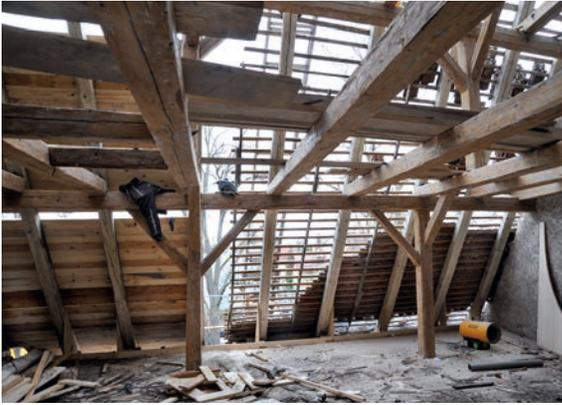
Abb. 17: Abgedeckter Dachstuhl.
