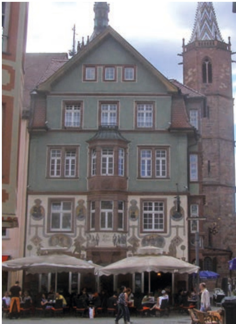
Ein Meisterwerk der Fassadenmalerei in Villingen von Albert Säger ist auch das Haus Obere Straße 13, in dem sich heute das Eiscafé Raben befindet. Es hat eine alte Gastronomie-Tradition in der Villingen Innenstadt.
