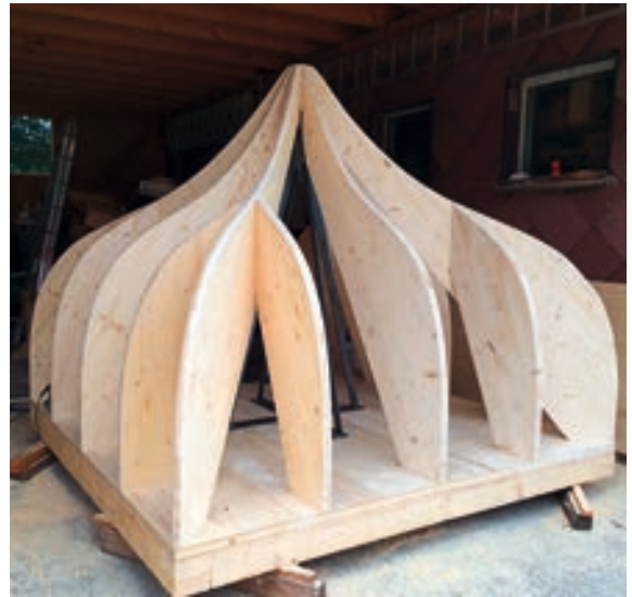
Abb. 11: Fertig abgebundene Turmkuppel mit Grat- und Schiftersparren.
