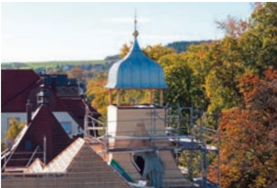
Abb. 14: Montierte Kuppel auf dem Turmschaft und fertig eingelattetes Hauptdach.
