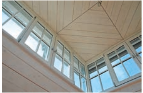
Abb. 16: Blick in das Turmzimmer mit Rautenschalungsdecke.
