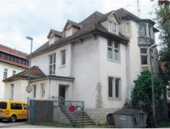
Abb. 8: Gebäudezustand im Jahr 2011 vor der Sanierung und ohne Turm.
