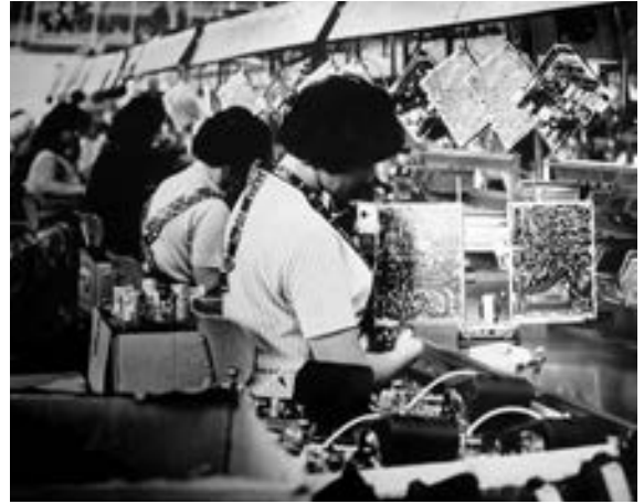
Abb. 4: Frühe Leiterplattenbestückung für Fernsehgeräte.
