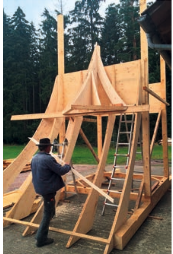
Abb. 10: Abbinden des Turmschaftes mit bereits seitlich ange-bautem Gaupendach.
