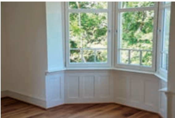
Abb. 19: Detail Fenster mit Brüstungsvertäferung.
