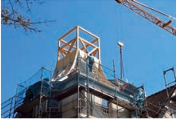
Abb. 12: Aufrichten des Turmschaftes.
