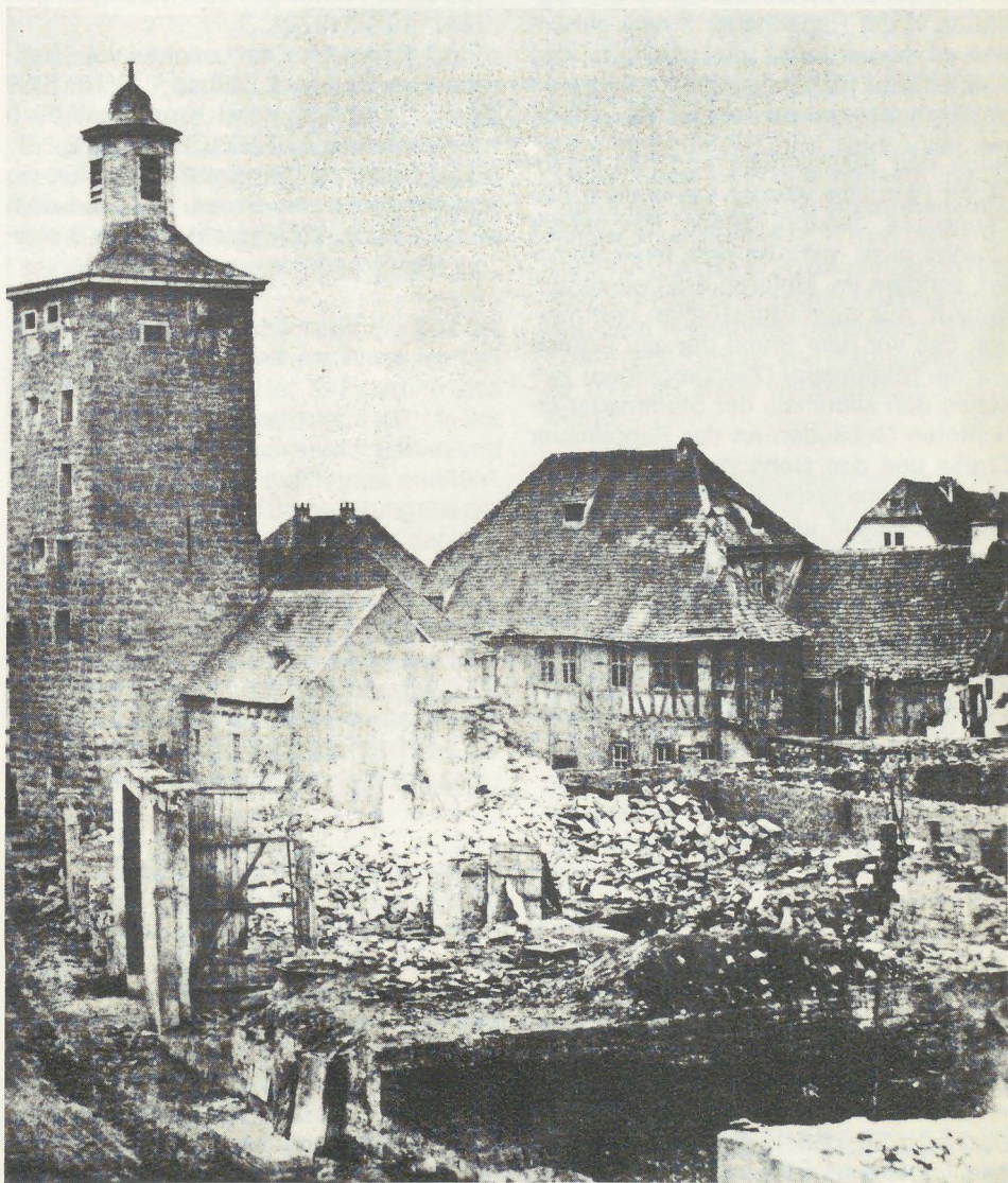
Brandplatz in der Kirchgasse vom Kirchenvorplatz aus
