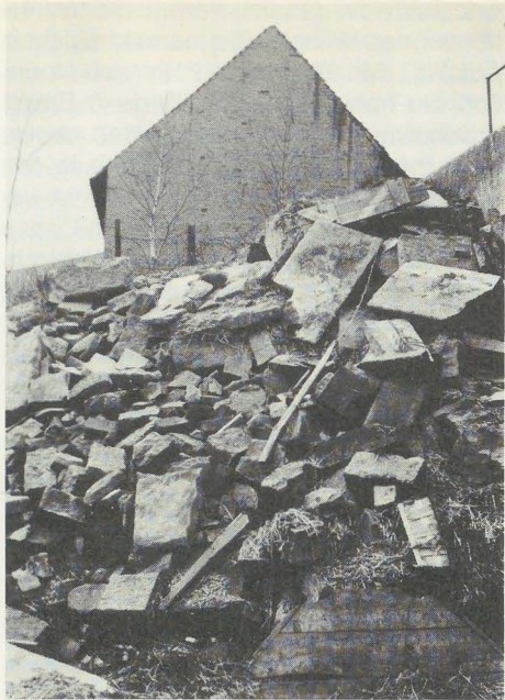
Trümmerberg hinter der Brettener Straße, durch Jagdbomberangriffe zerstörte Scheunen. Der Brandgiebel dahinter hielt stand.
