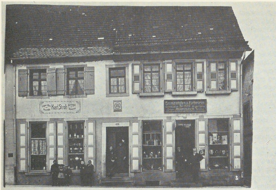
Die Wohnhäuser Stroh und Huber in der Rappenaue Straße. Die Häuser wurden von der „Palmbräu“ schrittweise aufgekauft und wegen des Baus des neuen Sudhauses abgerissen. Unter der Haustüre (Nr. 438) links A. K. Stroh mit ihrer Mutter; unter der Haustüre daneben Heinrich Vogel und Heinrich Huber.
