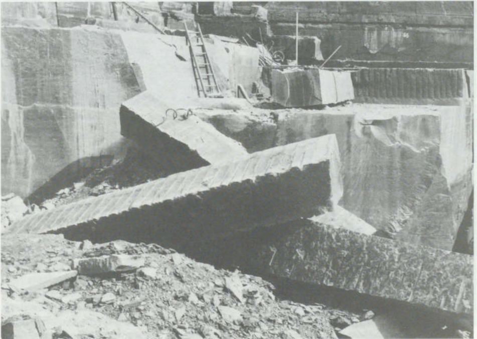
Steinbruch Mühlbach. Gewinnung von Felsblöcken zur Säulenherstellung
