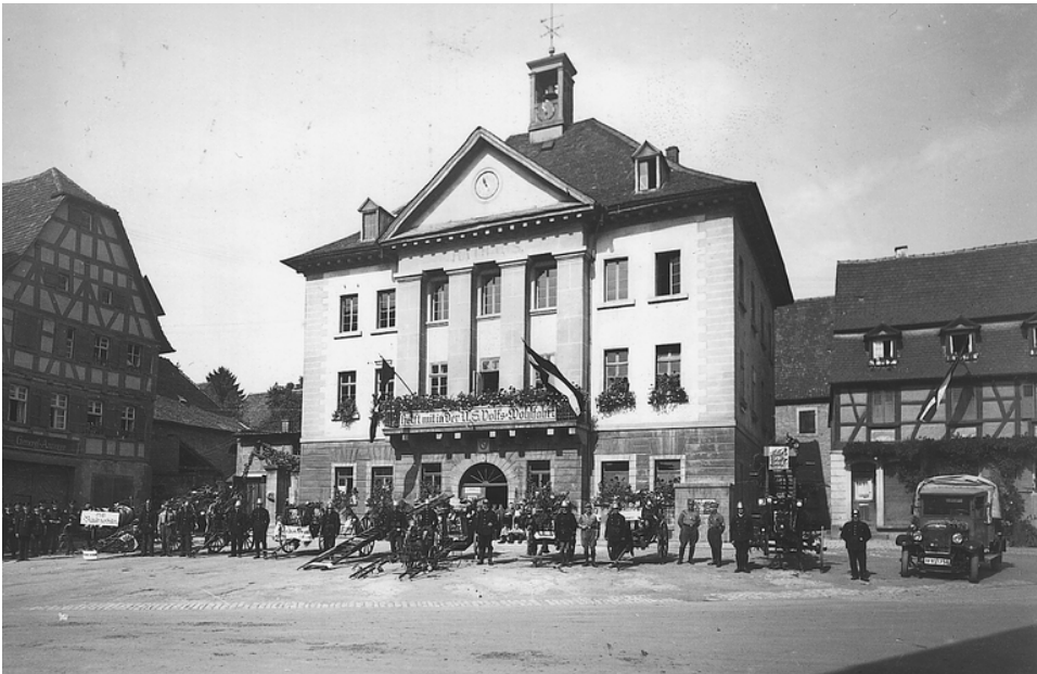
Ausrüstung der Feuerwehr 1932 auf dem Marktplatz zum Feuerwehrtag 1932. Von l.n.r. Schlauchwagen, Leiterwagen Stadtspritze I, Hydrantenwagen, Leiterwagen, Spritze der Rettungsmannschaft, Wasserwagen, Hydrantenwagen, Stadtspritze II und mechanische Leiter von 1904. Das rechte Fahrzeug gehörte nicht zur Feuerwehr.
