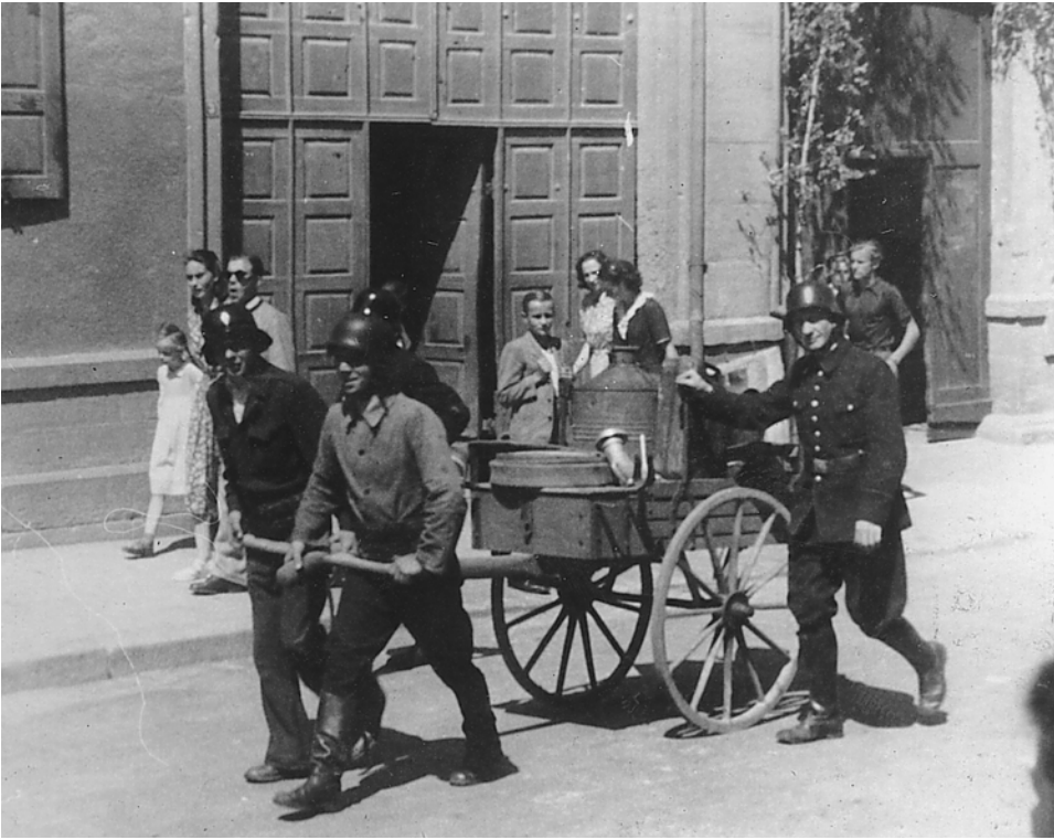
Hydrantenwagen bei den Heimattagen 1950 in der Adelshofer Straße vor dem heutigen Eingang zur Gastaus „Palmbräuhaus“ (Scheunentor mit eingesetzten Kassetten).
