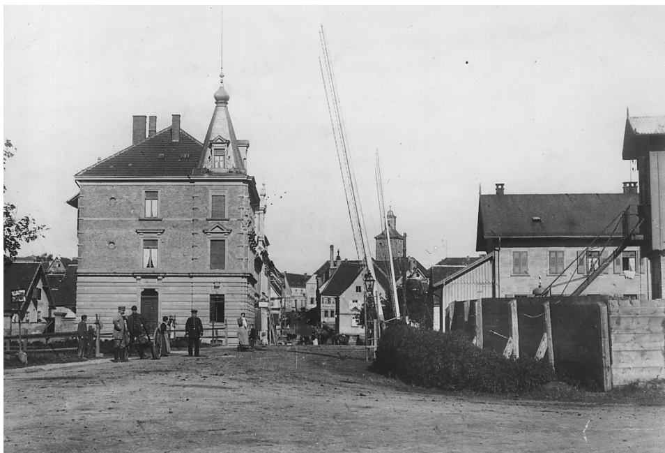
Das ehemalige Eppinger Postgebäude am Bahnübergang um die Jahrhundertwende.
