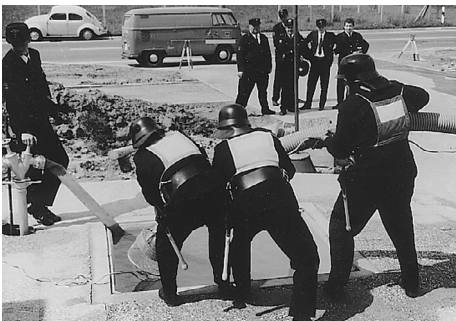
Zu Wasser bringen der Saugleitung.
