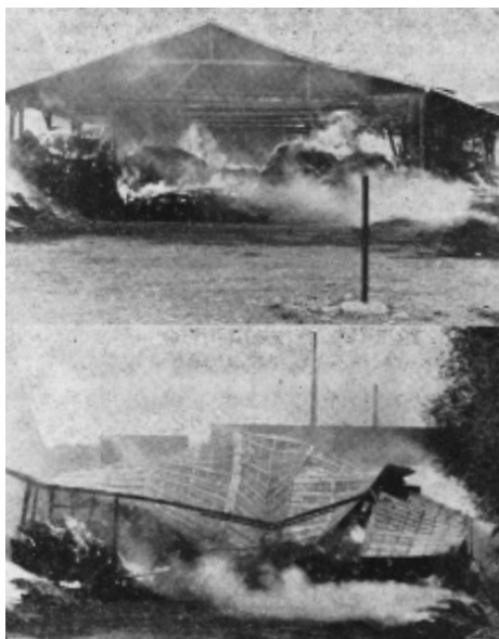
Brand der Veith'schen Dreschhalle am 7. Sept. 1953. Oben: Die Dreschhalle kurze Zeit nach Ausbruch des Brandes. Unten: Die nach 25 Minuten in sich zusammenstürzende Halle.
