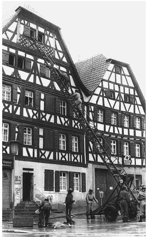
Zweirädrige mechanische Leiter mit drei Leiterteilen und bis 14 m ausziehbar bei einer Übung der Feuerwehr auf dem Marktplatz.
