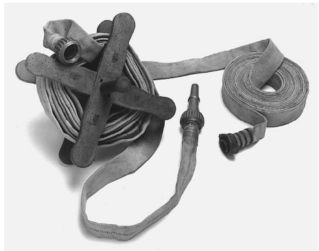
Hanfschlauch mit Schraubgewinde auf einer Schlauchhaspel und kurzem Strahlrohr aus Messing (links). Es sind Innen- und Außengewinde vorhanden. Hanfschlauch passend zur Spritze von 1802 (rechts).
