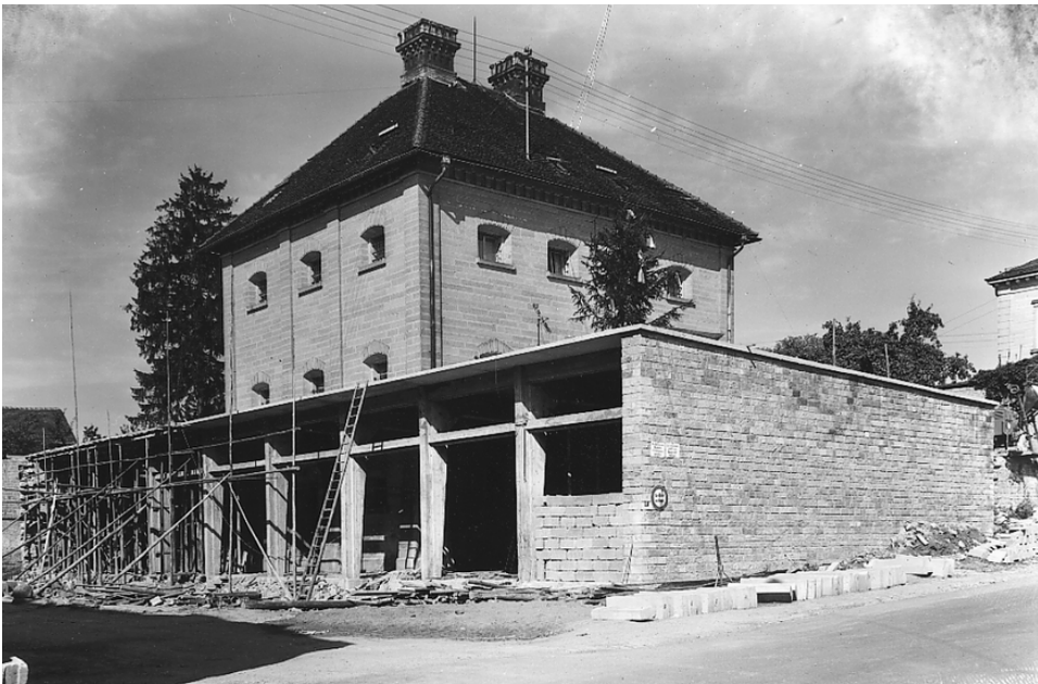
Gerätehaus während des Umbaus 1961.
