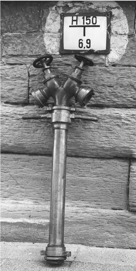
Hydrant aus Kupfer und Messing aus dem Jahre 1910 vor einem Hydrantenschild in der Kaiserstr. Die Hydrantenschilder wurden zum besseren Auffinden oft zusätzlich mit einem weißen Kreis gekennzeichnet.
