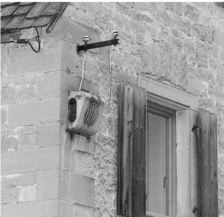
Lautsprecher der Rundrufanlage innerhalb des Ortes (hier ein Bild von der ehemaligen Anlage in Elsenz)
