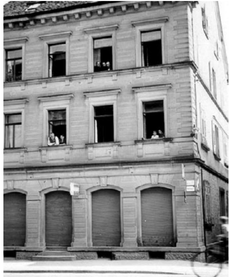
Ansichten der Eppinger Brettener Straße in den 30-er Jahren. Mitglieder der Familie Frank blicken aus den Fenstern ihres Hauses Brettener Straße 21
