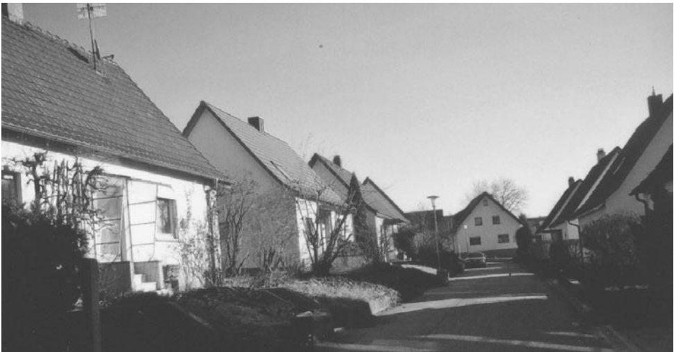
Alte Siedlung - Heimstättenweg von Westen 1939 Bad. Heimstätte Karlsruhe/Baultg. Hermann Fallert
