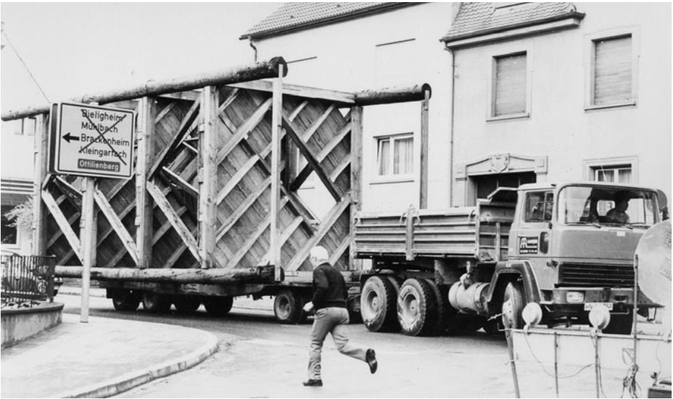
Transport des Turmgerüsts von der Halle der Fa. Mack zum späteren Standort
