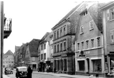
Brettener Straße mit dem Haus der Franks (3-stöckige Sandsteinfassade)
