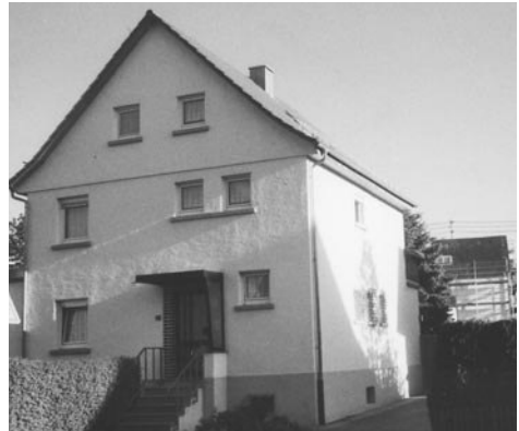
Adolf Brenkmann 1935 Waldstr.18, 1935. Die zum Haus gut passenden einfachen Schmuckglieder wurden bei der Renovierung nach dem Kriege beseitigt. (Arch. Baumeister Hermann Faller)
