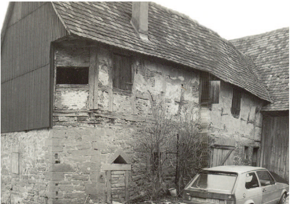
Abgerissenes Umlandhaus in Eppingen-Kleingartach
