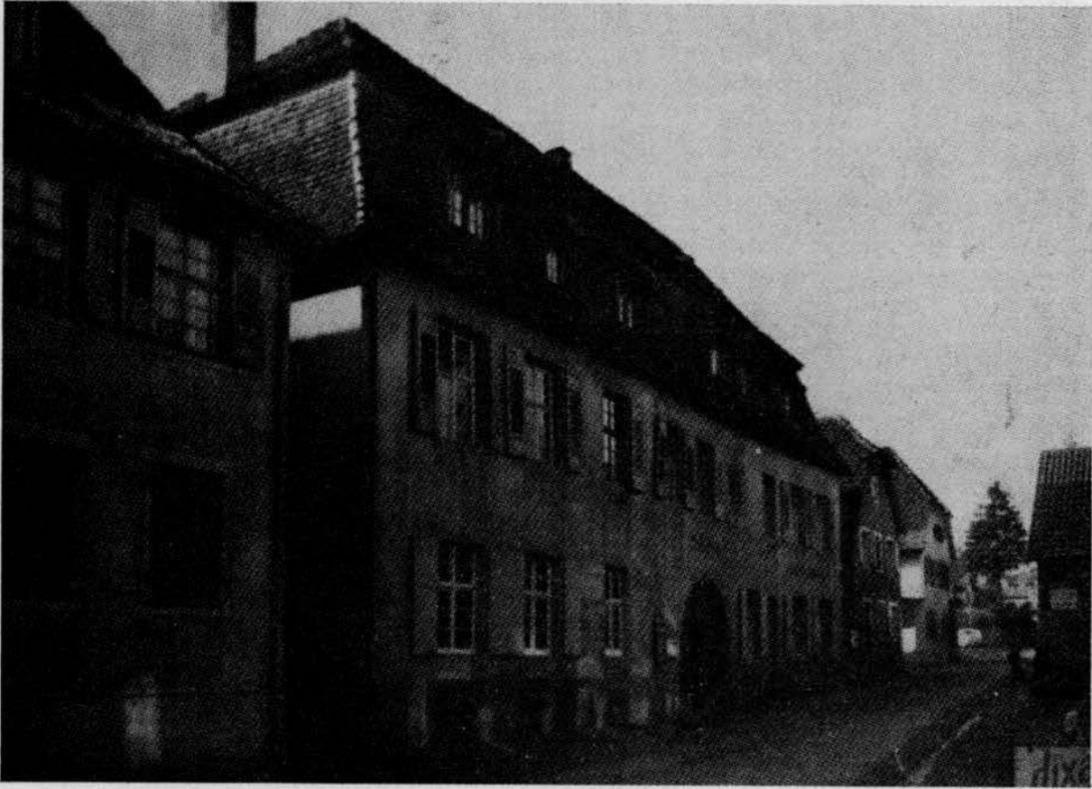
Der von Endingen'sche Stammhof, volkstümlich einfach Stammhof genannt, in der Thomasstraße zu Ettenheim, heute im Besitz der Stadt. Barocke Dachung aus dem 17. Jahrhundert.
