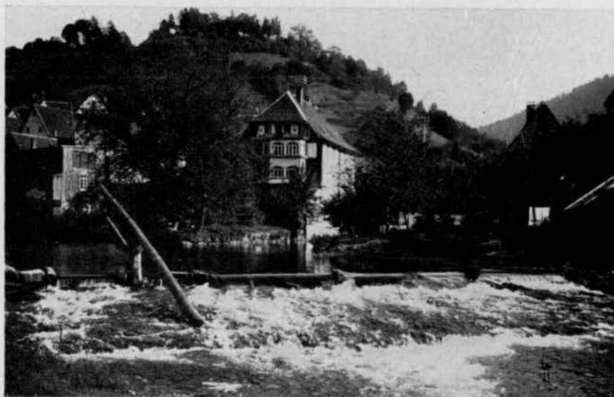
Altes Flößerwehr: der Hochmutsteich bei Schiltach mit geöffneten Fahrloch und Gamper (= Stauvorrichtung).
