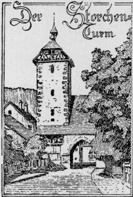
Storchenturm bzw. der lange Turm von Zell a. H. Links von der Durchfahrt einige kleine Kanonen aus dem 17. Jahrhundert. Einziger, noch erhaltener Stadtturm, in der Nähe des Bahnhofs.
