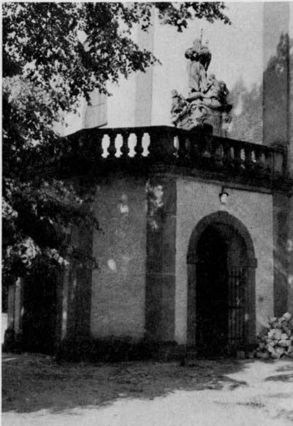
Brunnenkapelle der Landolinuskirche = Anbau vor der westlichen Giebelwand. Darüber die Statue des hl. Landolin. Im Innern ein quadratischer Brunnenstock, aus dem nach jeder Himmelsrichtung hin das Wasser herausfließt. An der Wand eine Inschrift. Aufn.: E. Ohnemus
