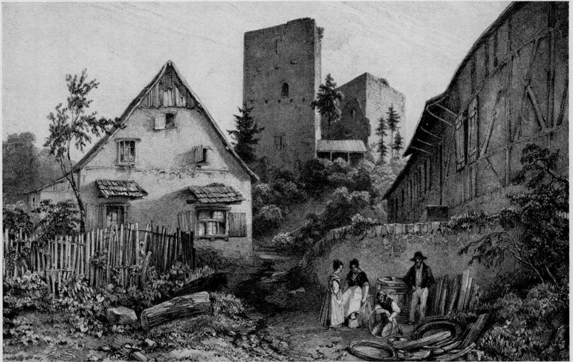
Burg Alt-Windeck bei Bad Hub. Dieser Wirtschaftshof steht nicht mehr. Steindruck von Gihant Frères.
