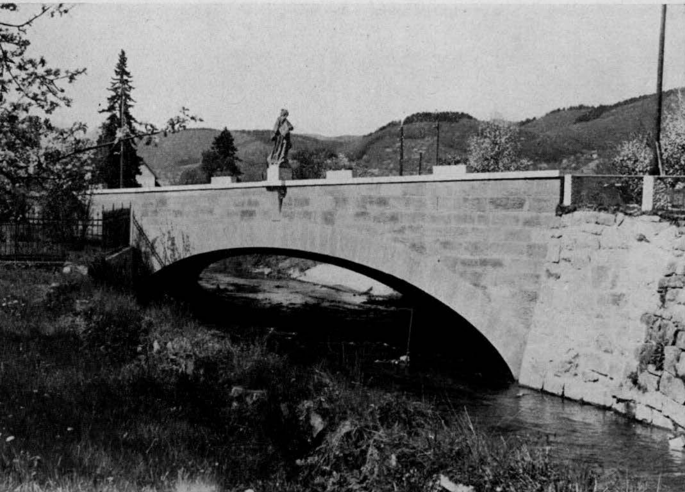
Gutleutbrücke Haslach i. K.; Verbreiterung der alten Brücke durch wachsenden Verkehr erzwungen. Nach Beratungen zwischen Straßenbaubehörde und Staatlicher Denkmalpflege, in die sich die oberste Landesbehörde einschaltete, wurde diese hübsche Lösung gefunden. Leider konnten die früheren zwei Brückenbogen nicht erhalten werden, aber wie früher Sichtflächen der Brücke gemauert. Aufn.: Olga-Drogerie, Haslach
