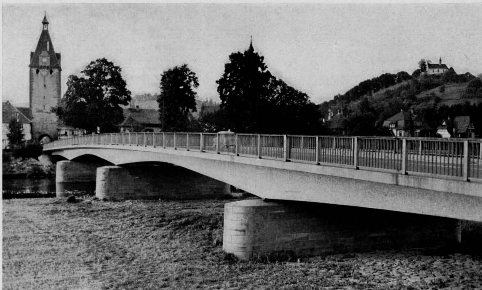
Kinzigbrücke in Gengenbach, leicht geschwungen in Spannbeton. Früher hier Brücke mit störendem Stahlhochbau. Vor der Brücke das Kinzigtor, rechts das Bergle mit St.-Jakobs-Kapelle, Rischer Barockturm in der Mitte verdeckt. Aufn.: Foto-Stober, Offenburg
