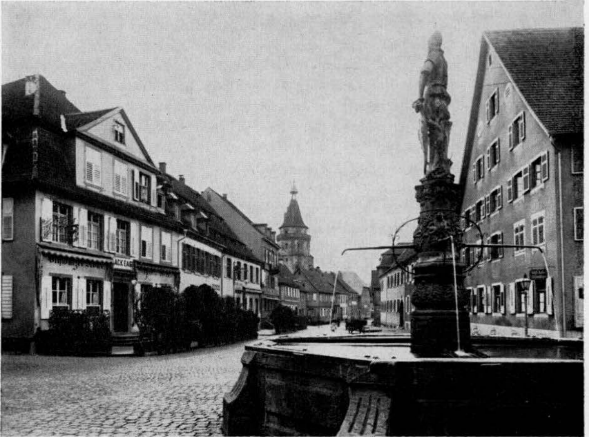
a) Hotel Adler vor 1900, gegenüber unter dem nüchternen Verputz Haus Hodapp; davor der alte Röhrenbrunnen mit der Schultheißenfigur, die die Hochgerichtsherrlichkeit der Reichsstadt versinnbildlichen soll. Im Hintergrund der Niggelturm, trotz festungsartigem, massigem Unterbau sehr anmutig im Aufbau. Ein weiteres glücklich renoviertes Gegenstück zu der Häusergruppe vor dem Niggelturm finden sie in „Ortenau“ 1960, S. 379. Bildarchiv: Hodapp, Gengenbach
