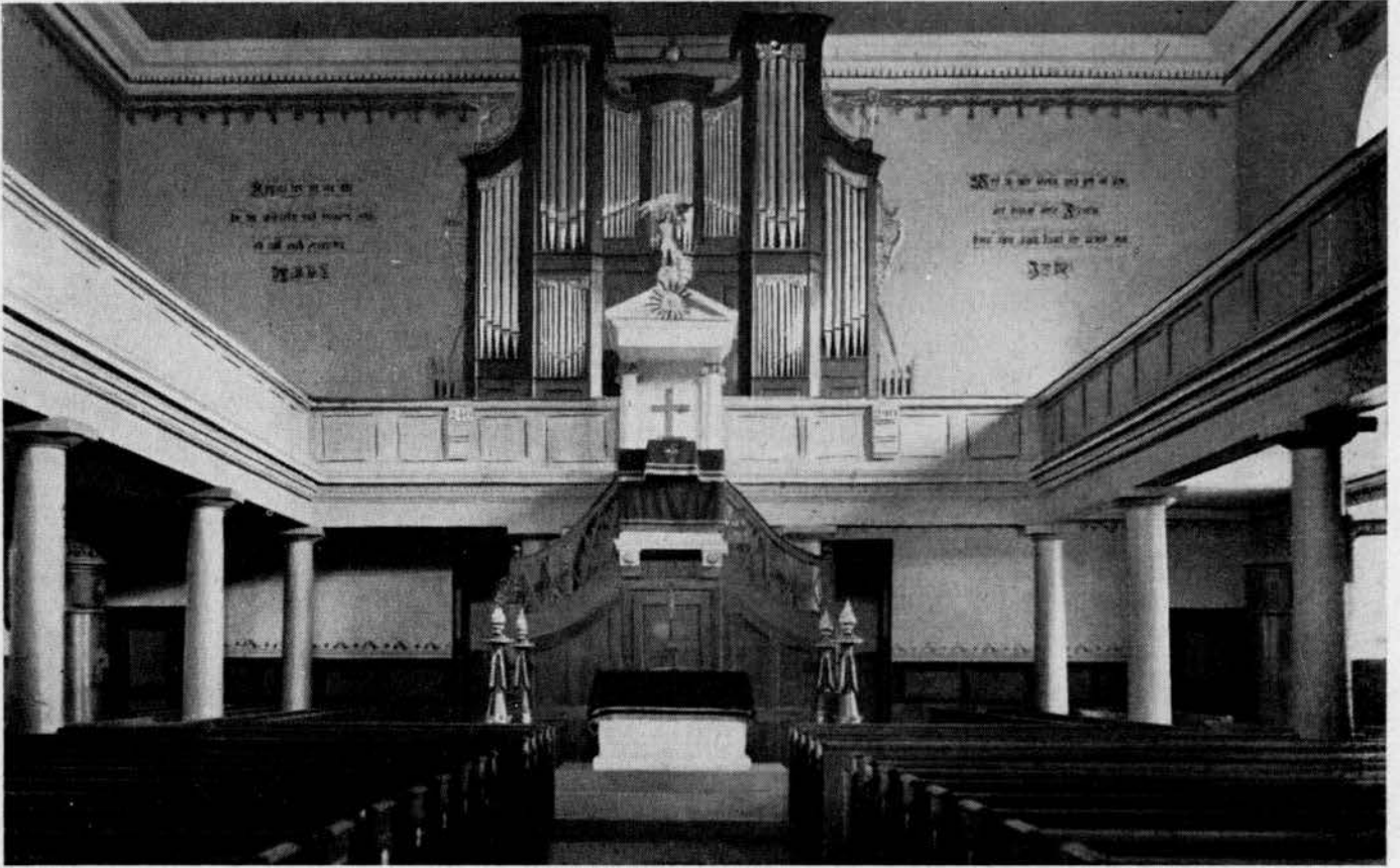
Inneres der Kirche zu Altenheim, erbaut 1808—1813; Pläne von Weinbrenner und Frommel. Ausgebrannt 3. April 1945.
