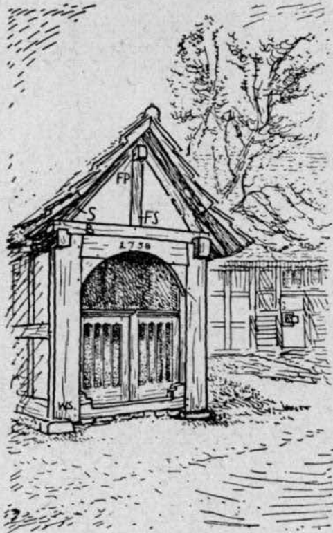
Abb. 5. Käfersberg, Offenburg. FP Firstpfette oder Firstbaum, FS Firstsäule, B Balken, WS Wandsäule, S Stockpfette
