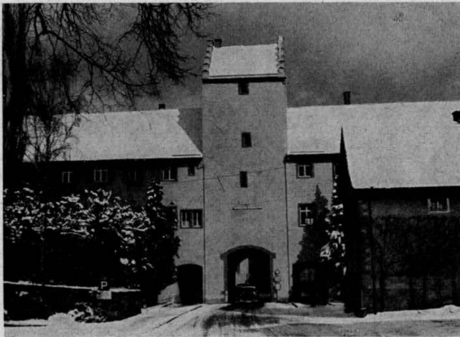
Wolfach. Stadttor (Landseite) nach Instandsetzung mit Durchbrüchen für Fußgänger Aufn.: Hesselbacher
