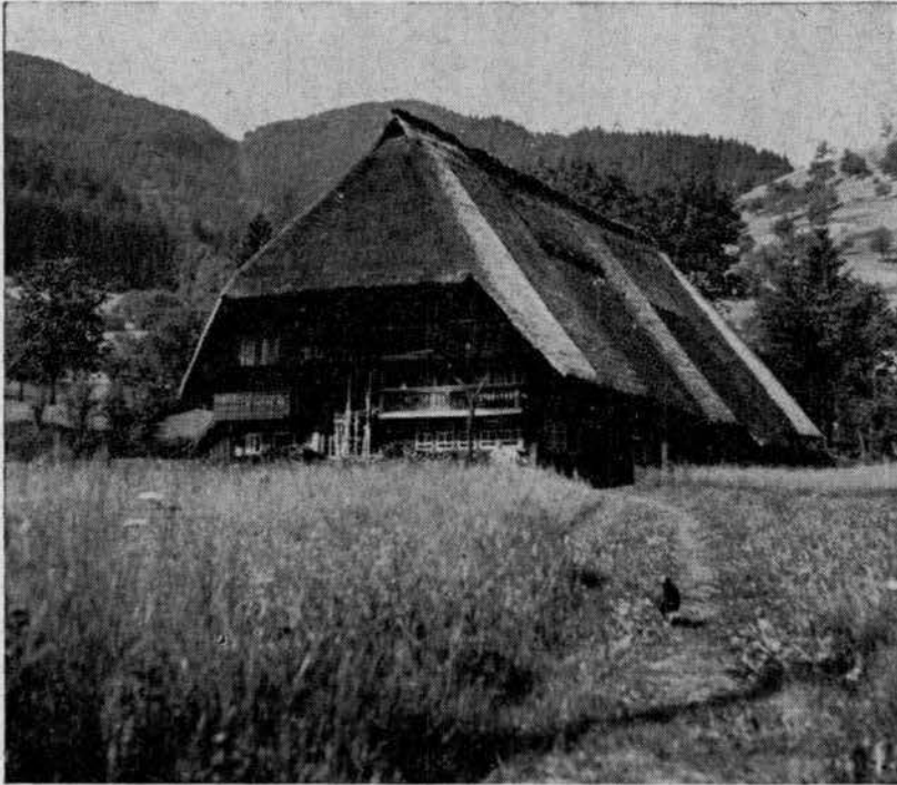
Abb. 19. Gutach, Vogtbauernhof. Erbaut 1573
