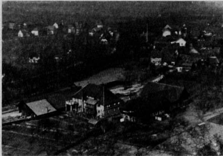
Die Deichmühle in Oberachern. Blick vom neuen Hochbehälter am Bienenbuckel
