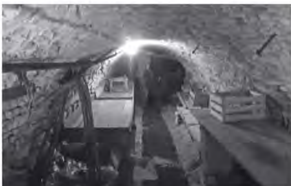
Rest eines Wehrganges der Garnison.
