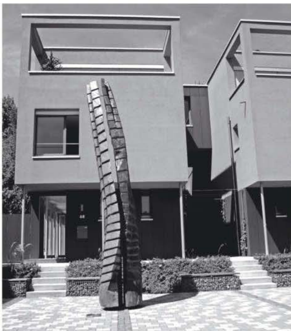
Lahr: Wohnanlage „Wohnen an der Eiche“. Foto: Coenen
