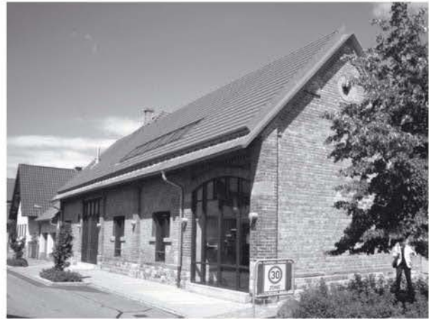
Bietigheim: Bürgerhaus Alter Farrenstall. Foto: Coenen
