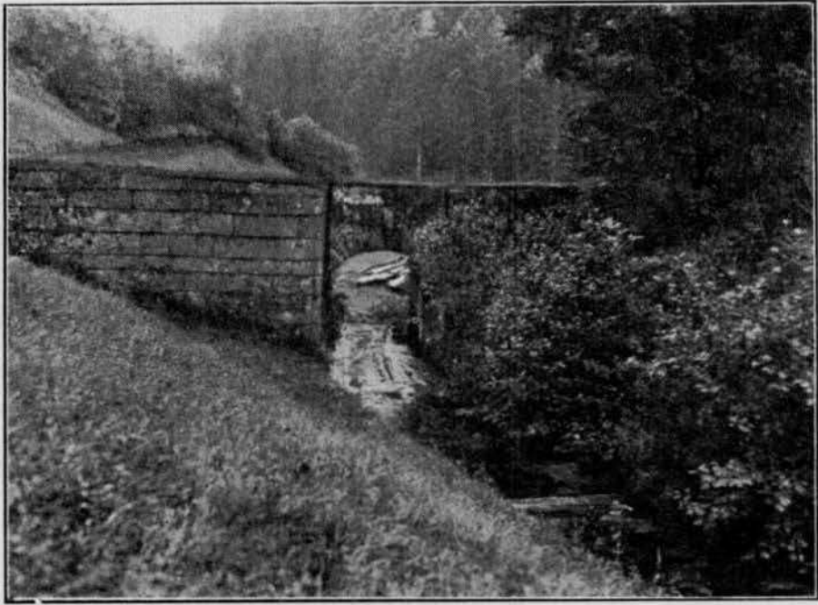
Die „Schwallung“ in Wittichen. Stauwehr des Witticher Floßweihers.
