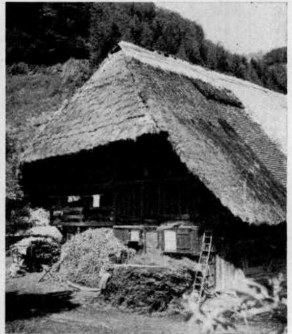
Abb. 5. Mischform. Fizenhof/Mühlenbach. Erbaut 1616. Diesen Formen fehlt die Stelzung und die Ruffbühne.
