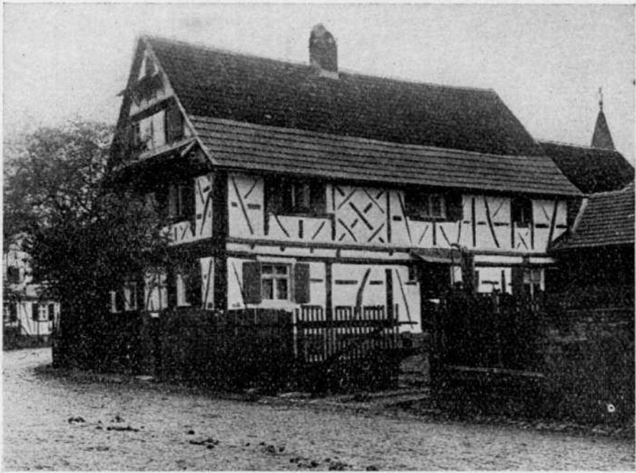
Zweistöckiges Haus in Scherzheim (Nr. 28).
