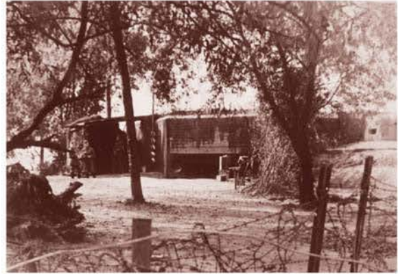
Landeinwärts gelegener Bunker
