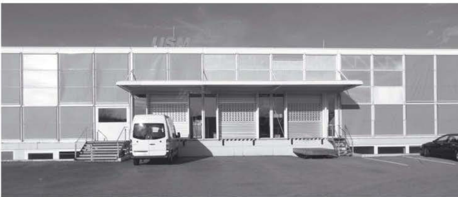
Rampe an der Südseite der USM-Betriebsanlage in Bühl. (Foto: Coenen)
