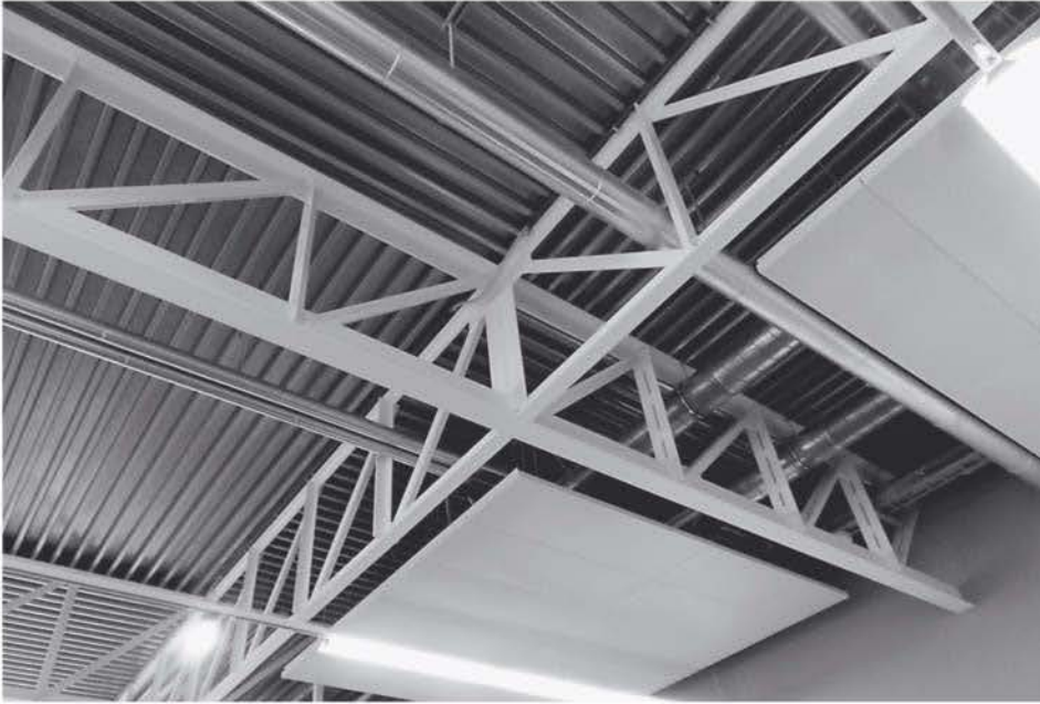
USM-Betriebsanlage Bühl: Beim Stahlbau- system Maxi bilden 1,20 Meter hohe Gitterträger aus verschweißten Stahl- profilen die Dachkonstruktion. (Foto: Coenen)
