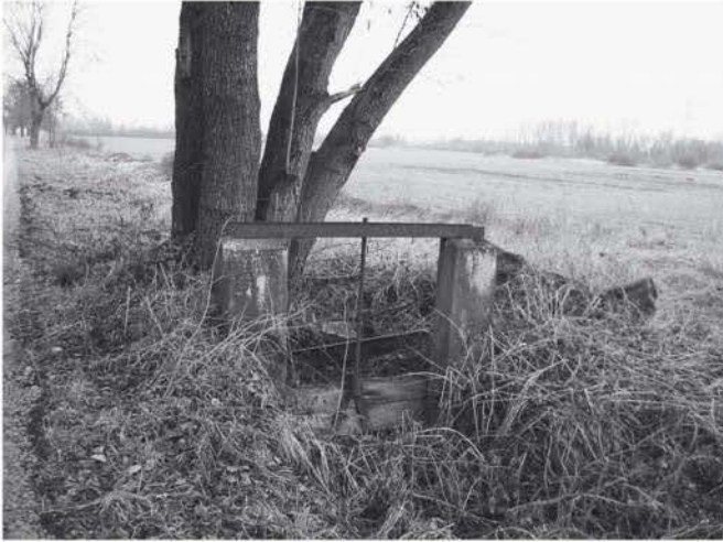
Stellfalle zur Aufstauung und Umleitung des Wassers
