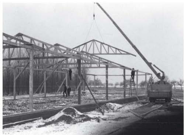
1965/1966 Bau der Schreinerei mit Teleskopkran
