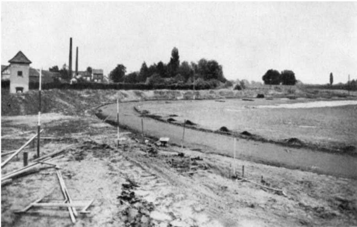
Aschenbahn und Zuschauerwälle im Bau
