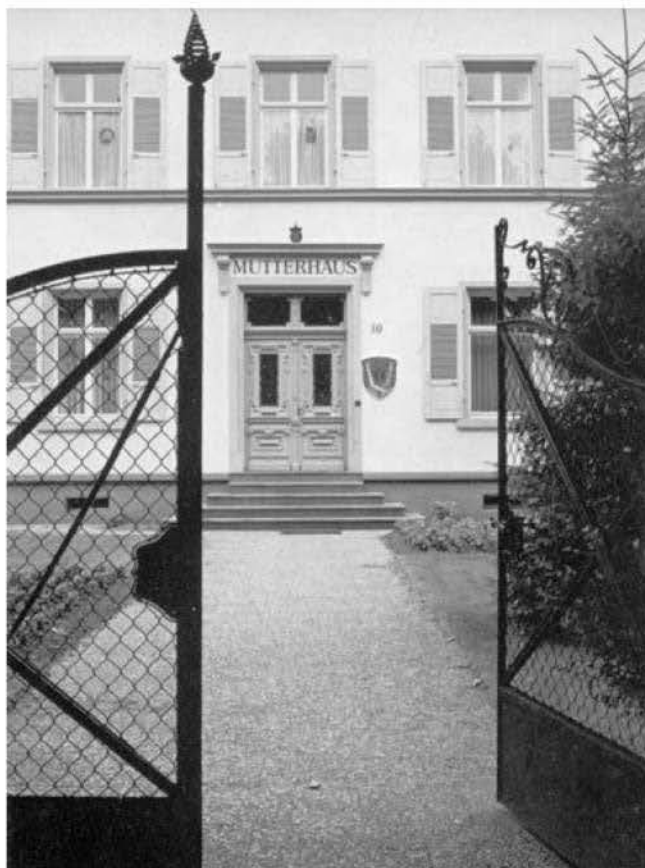
Pforte des Mutterhauses vor dem Umbau aus den 1960er Jahren
