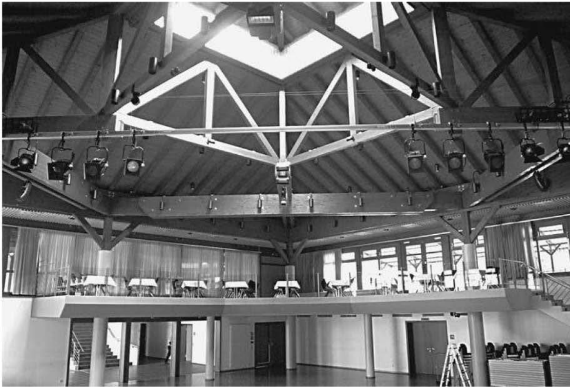
Großer Saal (Zustand: 2008)
