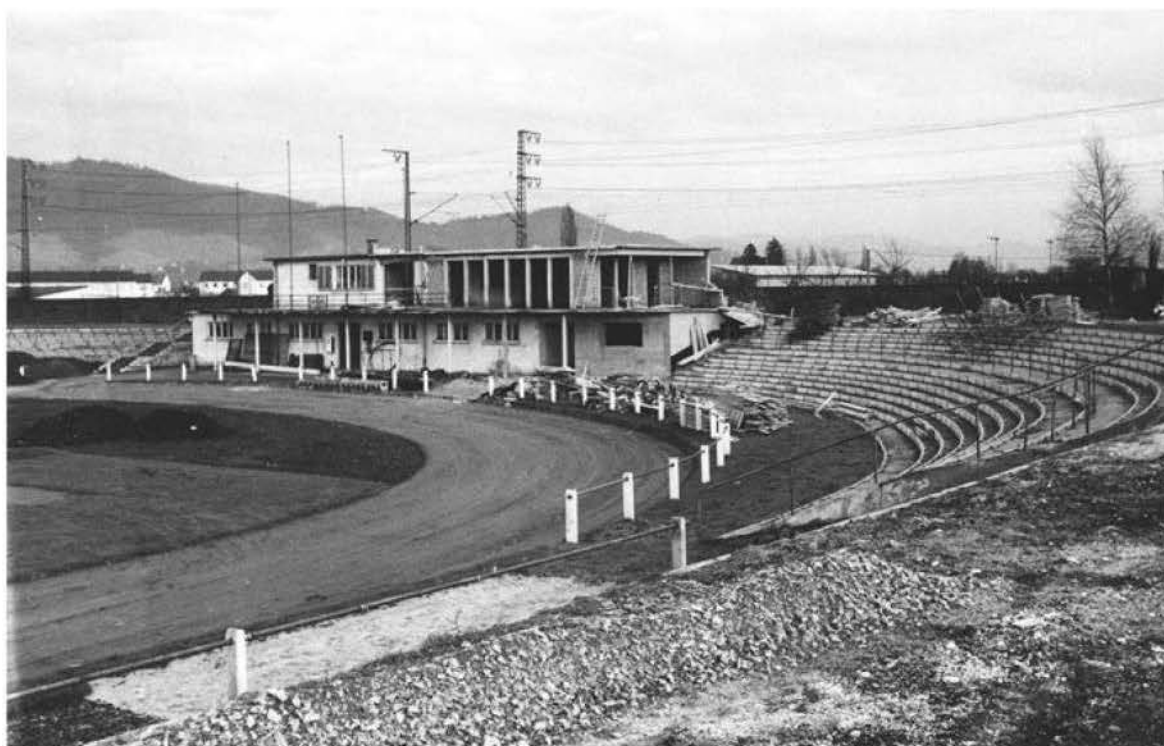
Turnerheim und Stehtribünen entstehen
