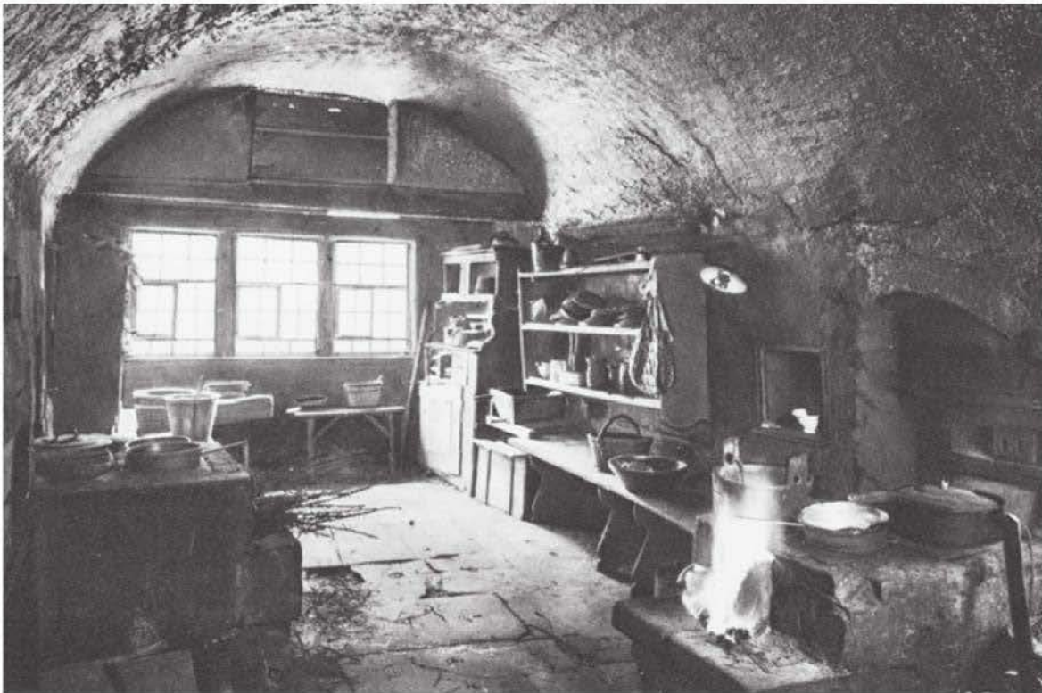
Abb. 3a: Die Rauch- oder Schwarzküche des Oberbauernhofs (Abb. 3) um 1930. Die gemauerten Herde an der rechten und linken Raumseite geben zu erkennen, dass die Küche auch hier von den Bewohnern sowohl der linken als auch der rechten Haushälfte gemeinsam genutzt wurde.
