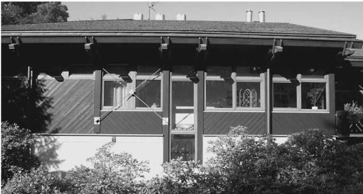
Fassade gegen die Bühlot (Detail) (Zustand: 2008)
