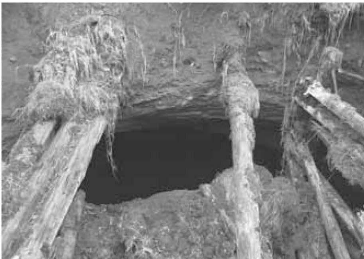
Bild 4: Stolleneinbruch in Baiersbronn/Mitteltal
