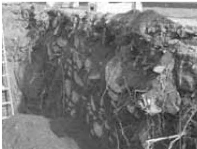
Bild 3: Die Fundamentsteine wurden ohne Mörtel versetzt, was verhinderte, dass die Nässe im Mörtel hochsteigt und die aufgehende vermörtelte Stadtmauer Schäden durch Feuchtigkeit nimmt. Kalkmörtel ist auf Dauer nicht wasserbeständig.
