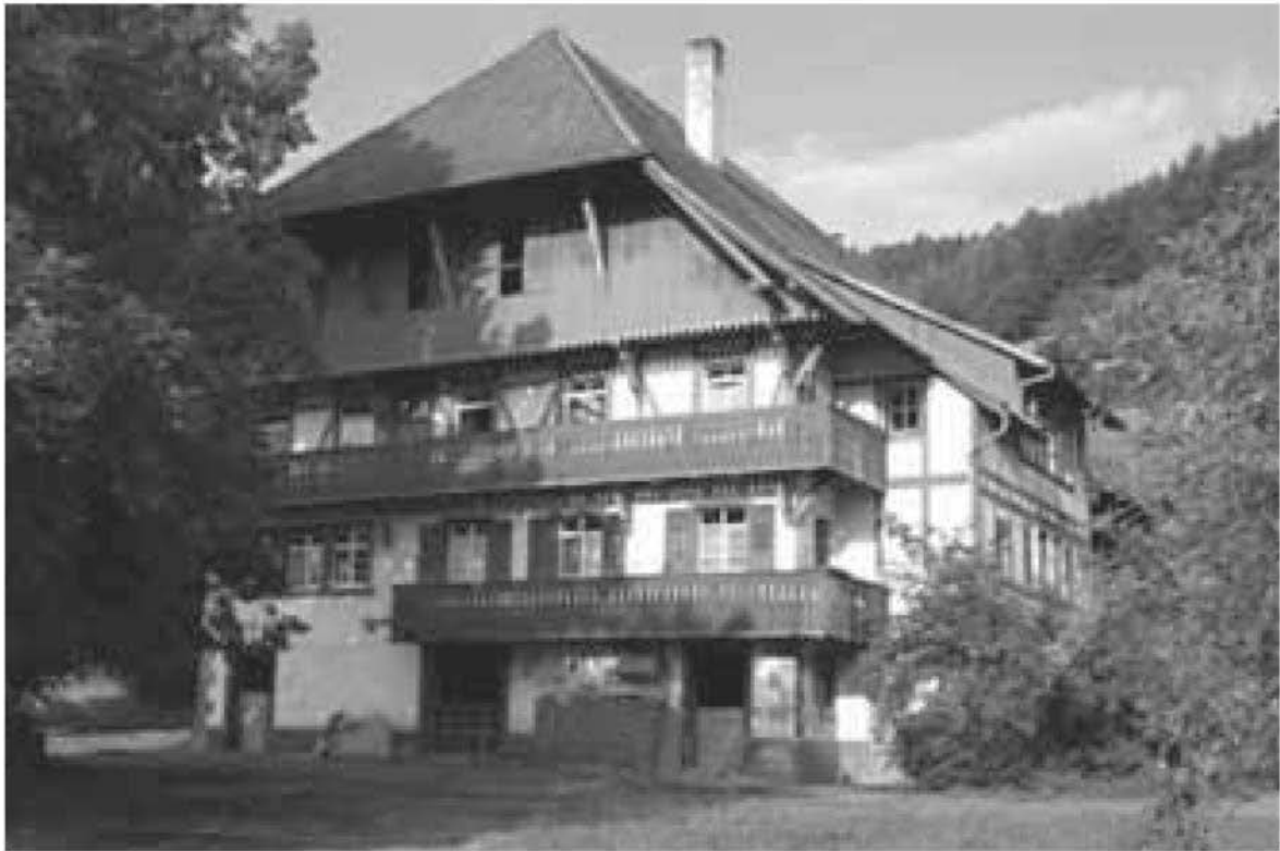
Bild 2: Der 1934/35 von Florian Gutmann und Maria Vetterer – nachdem das 1922 abgebrannte und danach neu errichtete Vorgängergebäude wieder abgebrannt war – errichtete, inzwischen unter Denkmalschutz stehende Dorfbauernhof in Hausach-Dorf im Jahre 2007.
