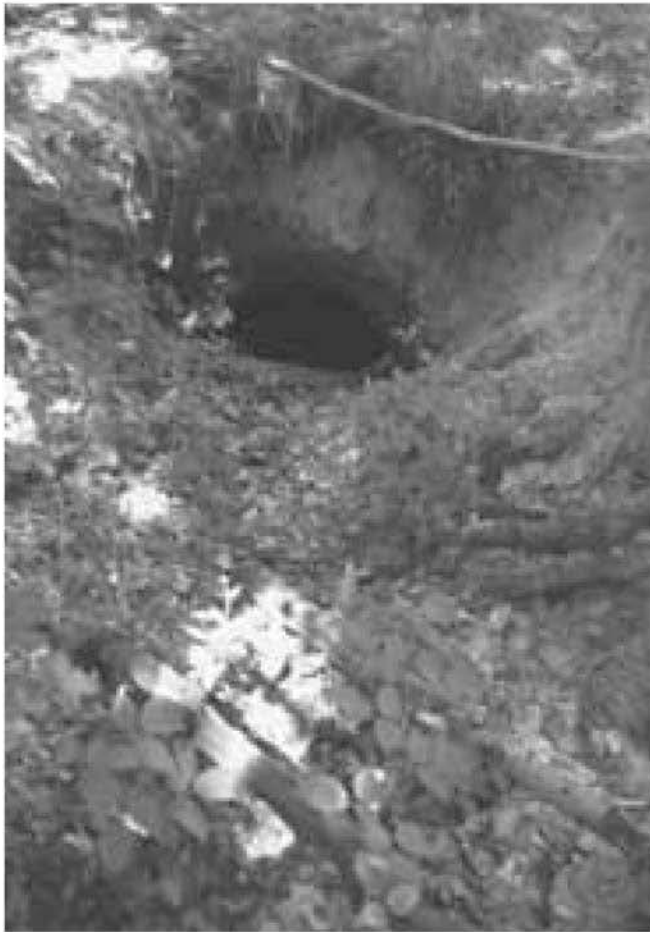
Bild 14: Verbrochener Stollen Durbach/Bohlsbach
