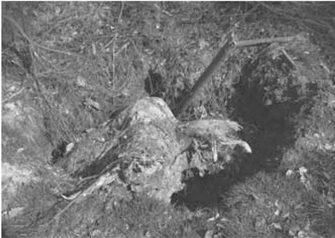
Bild 3: Einbruch eines Stollens
