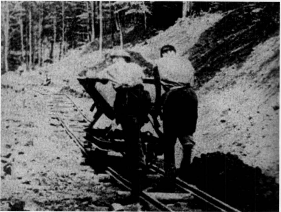
Noch erfolgt der Erdtransport beim Waldwegebau auf der Lore
