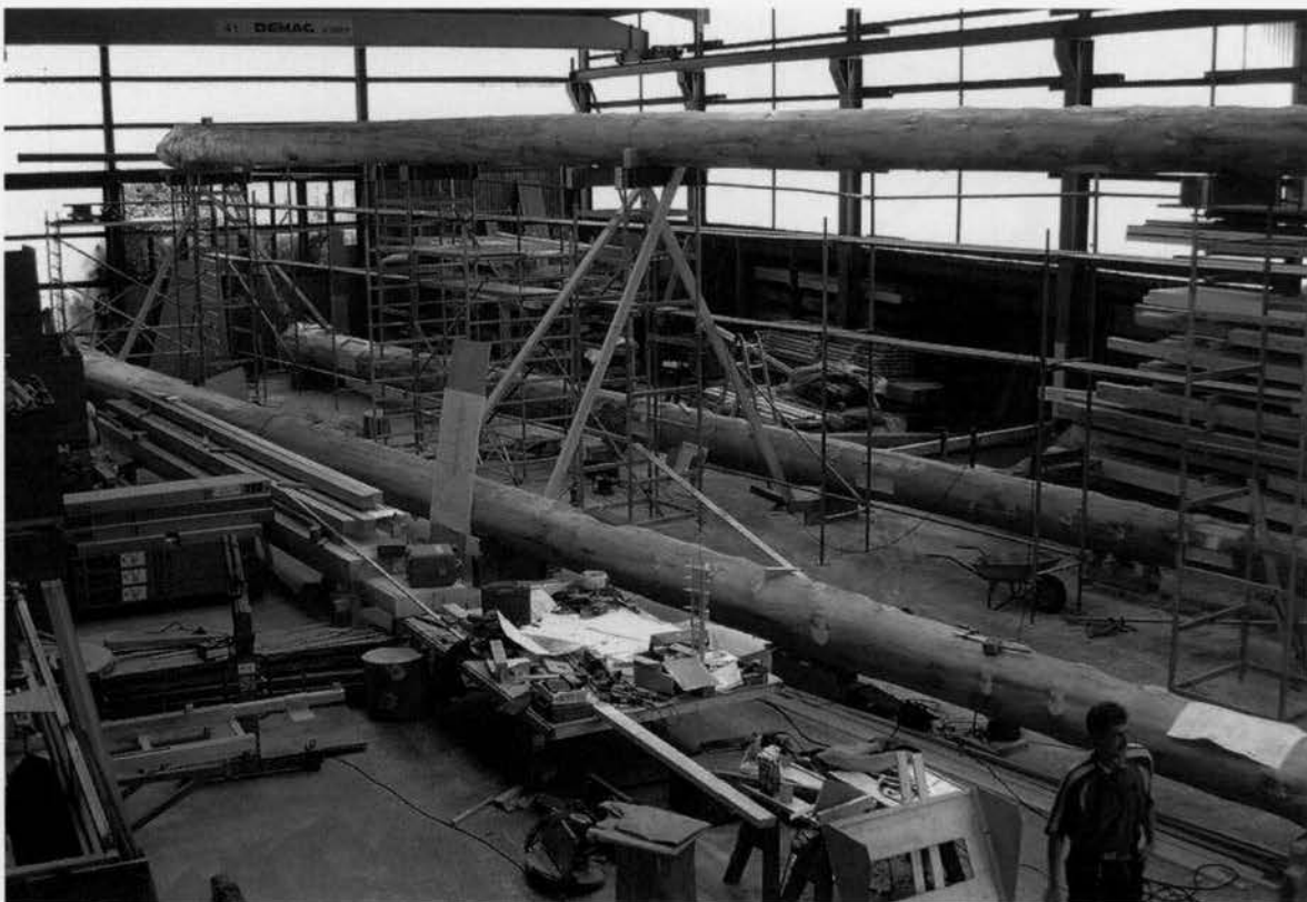
Die Stämme werden in der Zimmerei vormontiert
