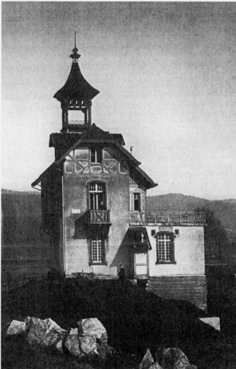
Das Schlössle vor der Beschädigung
