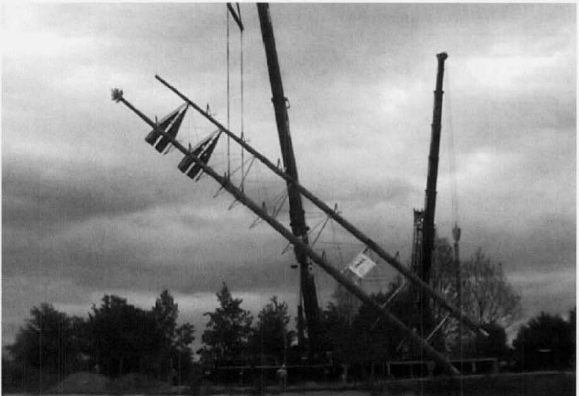
Der Turm wird in die Vertikale gebracht
