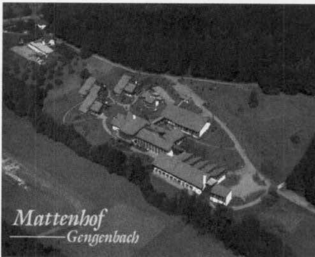
Der Mattenhof bleibt auch künftig als selbstständige Ausbildungseinrichtung erhalten. Hier eine Aufnahme noch vor Sturm „Lothar“
