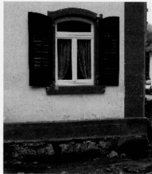
Bild 10: Alter breiter Eingang zu einem Keller mit Sandsteingewölbe. Der Kellerraum wurde etwa um 1900 beim Umbau des Hauses als Schule mit Erdreich verfüllt. Über das Alter des Kellers kann zur Zeit noch keine Aussage gemacht werden.
