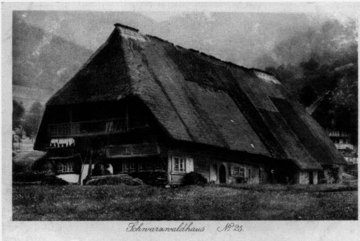
Bild 1: Der 1612 erbaute Vogtsbauernhof in Gutach um 1910 – er wurde 1964 zur Keimzelle des Schwarzwälder Freilichtmuseums, das seinen Namen trägt. Die Rundbogentür an der rechten Traufseite erschließt den dreiraumbreiten Wohnteil mit der Rauchküche zwischen Stube und Stüble.
