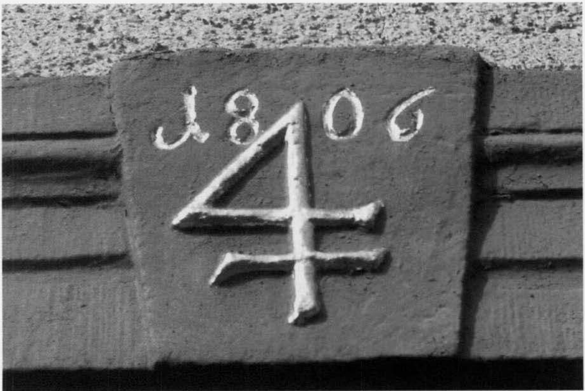
In der Schmieheimer Straße 7 trägt ein Türsturz die Jahreszahl 1806. In diesem Gebäude befand sich ab 1861 die Israelitische Schule.
