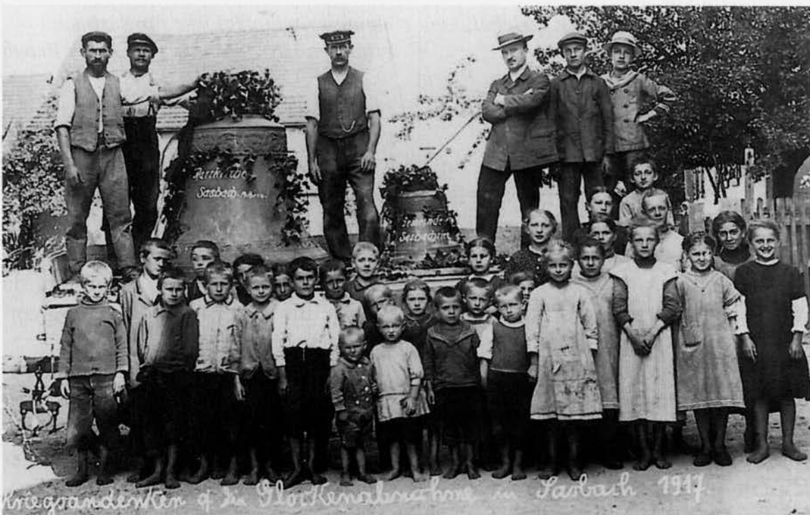
Arbeiter des Baubetriebes „Franz Ketterer“ mit den abgeseilten Glocken auf dem Kirchplatz in Sasbach im Juni 1917. Die barfüßigen Kinder verfolgen dieses traurige Ereignis und haben sich zu einem Erinnerungsfoto aufgestellt. Foto: Privat
