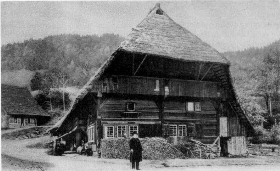
Bild 16: Ein weiteres nur zweiraumbreites Bauernhaus in Gutach ist der nach dem Lagerbuch von 1716 im Jahre 1715 von Christian Aberle erbaute Oberlehof – Foto um 1900. Die Küche an der rechten Traufseite und der im Bild leider nur schwach sichtbare Gang im Obergeschoss vor der linken Traufseite lassen erkennen, dass auch hier – wie beim Lehmshof (Bild 15) – bauliche Elemente des Kinzigtäler Hauses und des Höhen- oder Heidenhauses einfließen.
