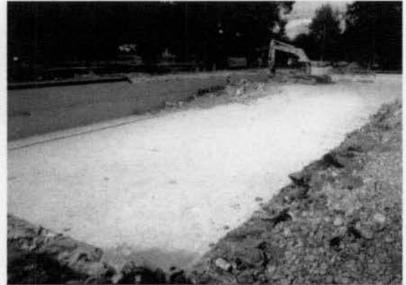
Abriss des Schwimmbeckens im Jahre 2002
