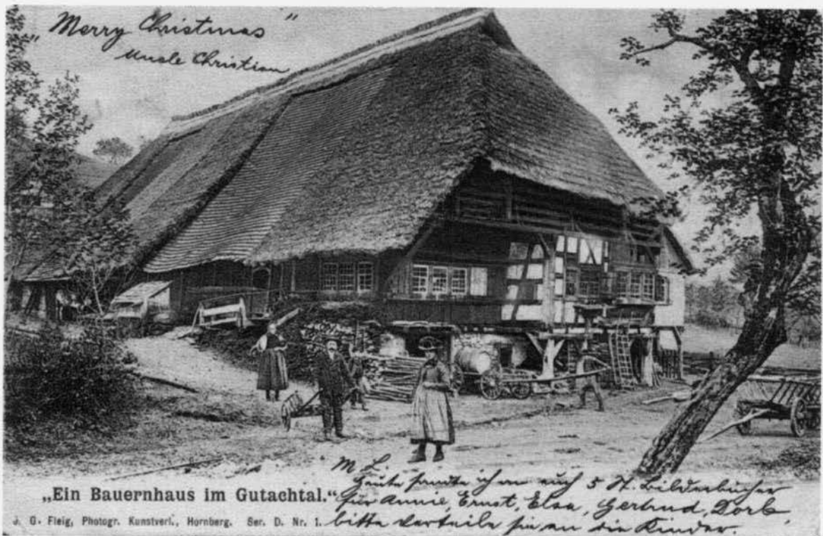
Bild 4: Der um 1590 erbaute eingeschossige Oberbauernhof in Gutach um 1900. Die Rauchküche – etwa in der Mitte der Frontseite des Hauses – wurde offensichtlich nachträglich bis zur Trippelflucht vergrößert, d. h., das im Bild zu sehende Fachwerk ist nicht ursprünglich.
