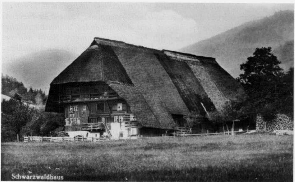
Bild 7: Auf dem um 1900 entstandenen Foto des um 1680 erbauten und 1914 abgebrannten Hinterschlauchbauernhofs in Gutach – einem typischen Gutachtäler Haus – ist keine Fachwerkwand in der Hausfront zu sehen. Auch im Bereich der Rauchküche – etwa in der Mitte der Giebelseite des Hauses – ist die ursprüngliche Ständer-Bohlenbauweise gut zu erkennen. Oberhalb der Küchentür am vorgelagerten Kücheneingang ist das Rauchgatter sichtbar, durch das ein Großteil des Rauchs vom Küchenherd und Kachelofen ins Freie gelangte; der Rest zog über den Dachraum und das Strohdach ab.
