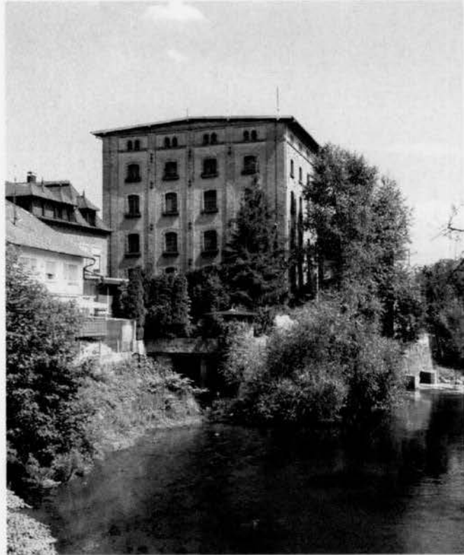
Blick von der Kinzigbrücke
