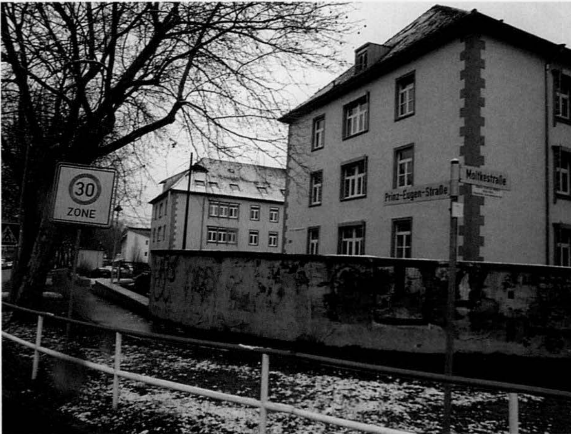
Gebäude der ehemaligen Artilleriekaserne, Offenburg. Zustand April 2005
