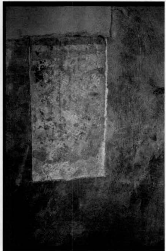
Wolfach, kath. Pfarrkirche St. Laurentius. Reste älterer Malerei (Vorhang?) auf einer tieferen Putzebene, vor 1470
