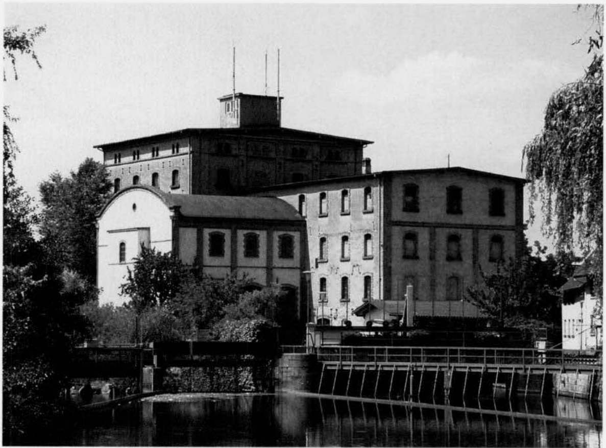
Anbau des Elektrizitätswerkes anno 1910
