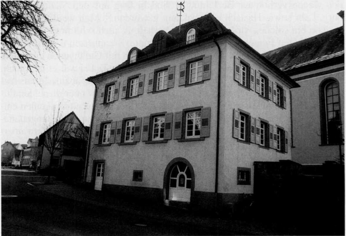
Die „Alte Schule“ in Niederschopfheim“
