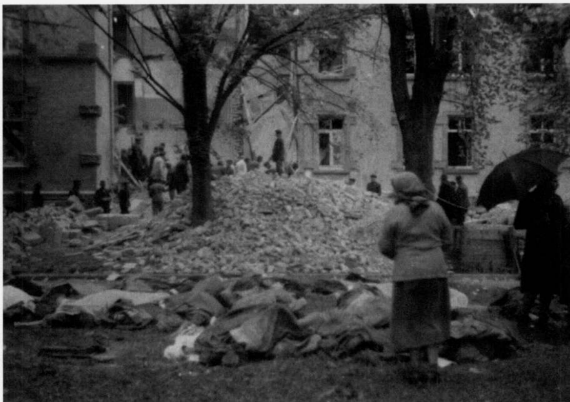
Am Tag nach den Sprengungen
