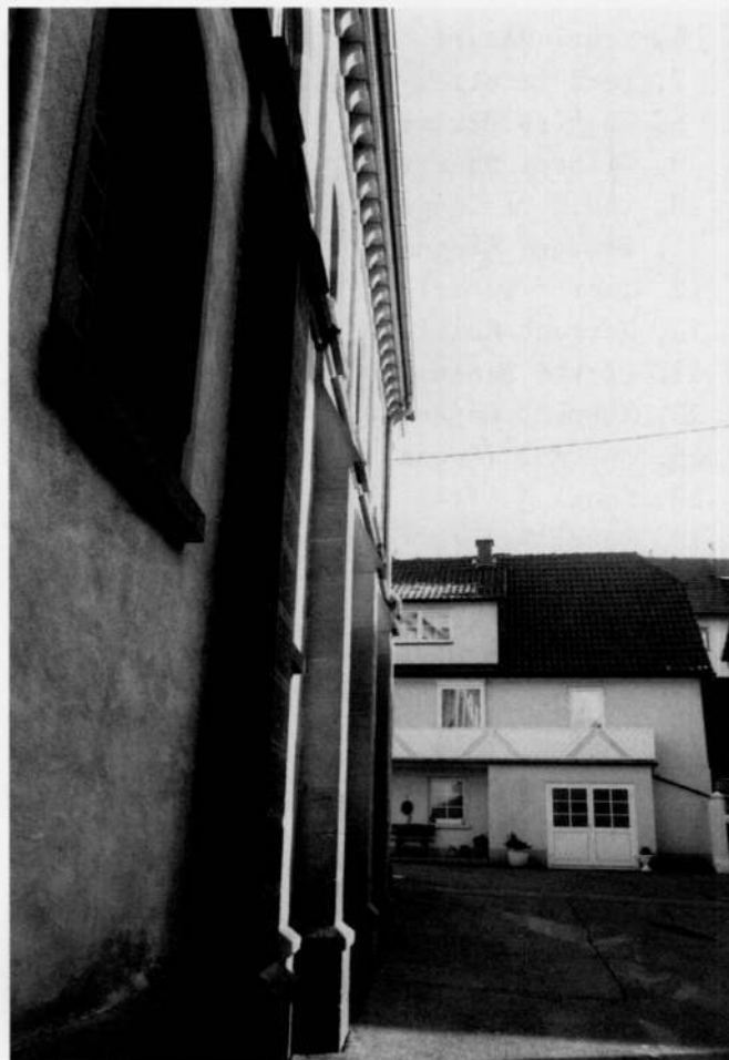
Das ehemalige Kantorenhaus hinter der Kippenheimer Synagoge Foto: Uwe Schellinger (2003)
