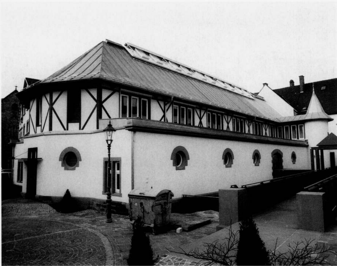
Außenansicht des Friedrichsbaus in Bühl, von der Franz-Conrad-Straße gesehen: Die basilikale Querschnittform des Festsaals ist deutlich erkennbar.
