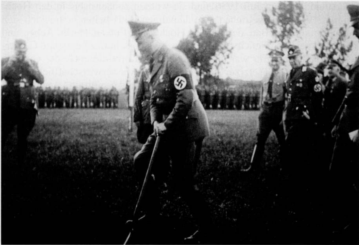
Erster Spatenstich am 2. Juli 1936. Bildarchiv des Vereins für Ortsgeschichte Memprechtshofen, vermittelt durch Heinz Großholz
