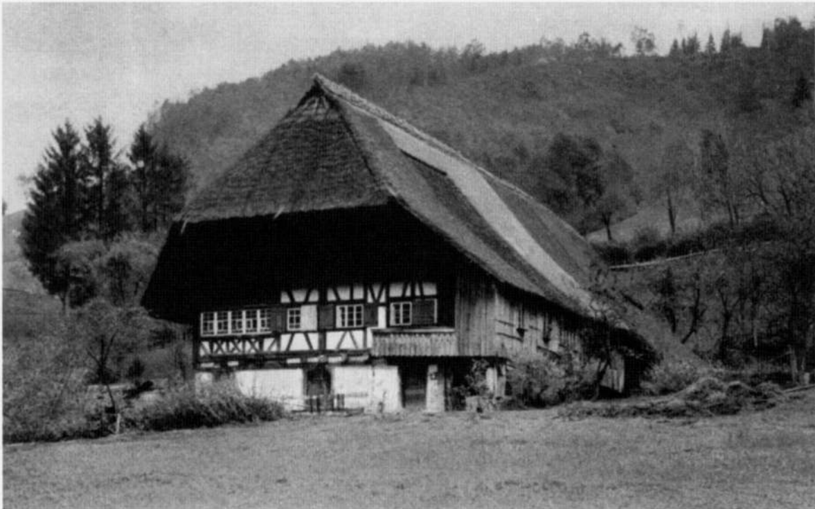
Bild 7: Der 1718 erbaute Fegershof vor Gelbach in Oberwolfach um 1910, eines der wenigen eingeschossigen Kinzigtäler Häuser mit strohgedecktem Walmdach und Fachwerk mit Flechtwerk-Lehmfüllung.
