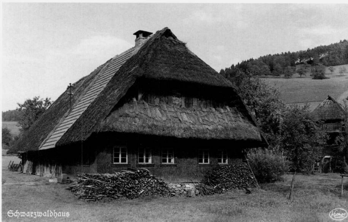
Bild 6: Auch der um 1610 erbaute Paulishof in Oberwolfach ist – wie der Jungbauernhof (Bild 5) – ein eingeschossiges Kinzigtäler Haus ohne steinernes Sockelgeschoss – Foto um 1920. Das Vieh stand auch hier im Stall hinter dem Wohnteil des Hauses. Da Kinzigtäler Häuser dieser Bauart relativ niedrig sind, bezeichnen die älteren Bewohner des Wolfstals derartige Bauernhäuser als „Bodenhöfe“.
