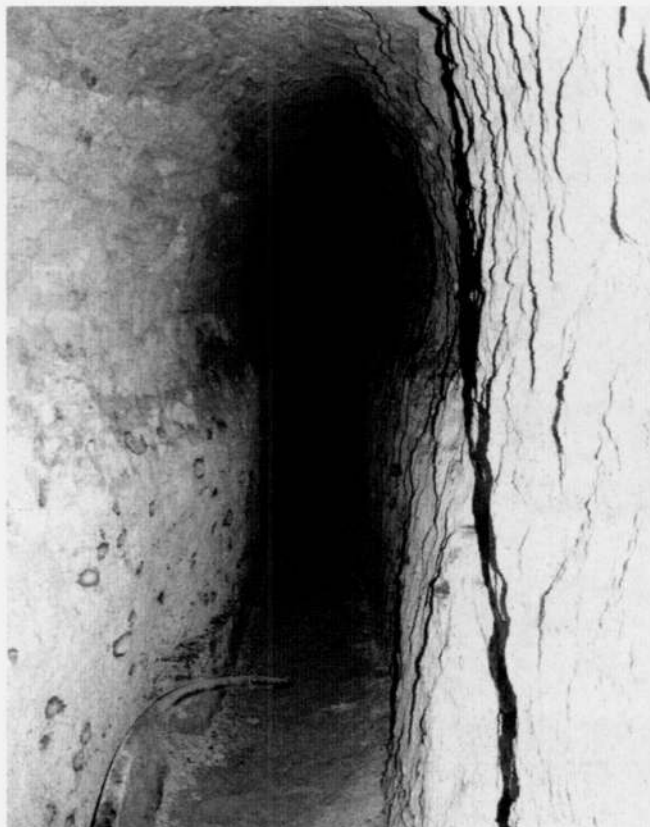
Diese Grube befindet sich beim „Kräherhof“ (Kräherkapf) in Oberreichenbach. Sie wurde in den letzten Jahren vom Hofbauern bei der Erstellung eines Schopfes entdeckt und ist 70 Meter lang. Weil die dort noch vorhandenen Erzspuren nicht bergbaugerecht abgebaut wurden, hat man darin wahrscheinlich nur nach Wasser gesucht. (Foto: Wolfgang Neuß)
