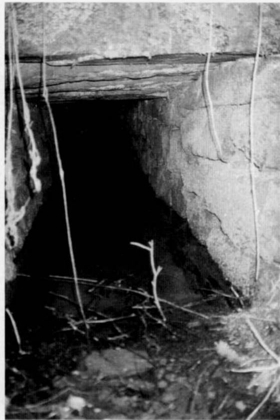
Stolleneingang einer Grube in Oberreichenbach oberhalb des Gasthauses „Sonne“.
