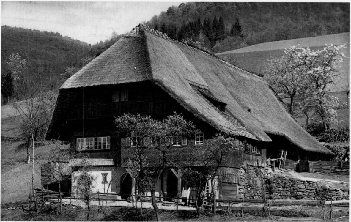
Bild 4: Der 1592 erbaute eingeschossige Fegershof am Wasser in Oberwolfach-Obertal um 1920. Der Hauptzugang zum Wohnteil befindet sich an der linken Traufseite des Gebäudes. Dieses Bild belegt, dass Hocheinfahrten an Kinzigtäler Häusern nicht einzig und allein von der Rückseite der Häuser ins Dachgeschoss führen. An diesem Haus führt die Hocheinfahrt von der rechten Traufseite ins Gebäude und zwar nicht – wie allgemein üblich – in die Dachebene, sondern in den Wirtschaftsteil des Gebäudes, unmittelbar hinter dem Wohnteil
