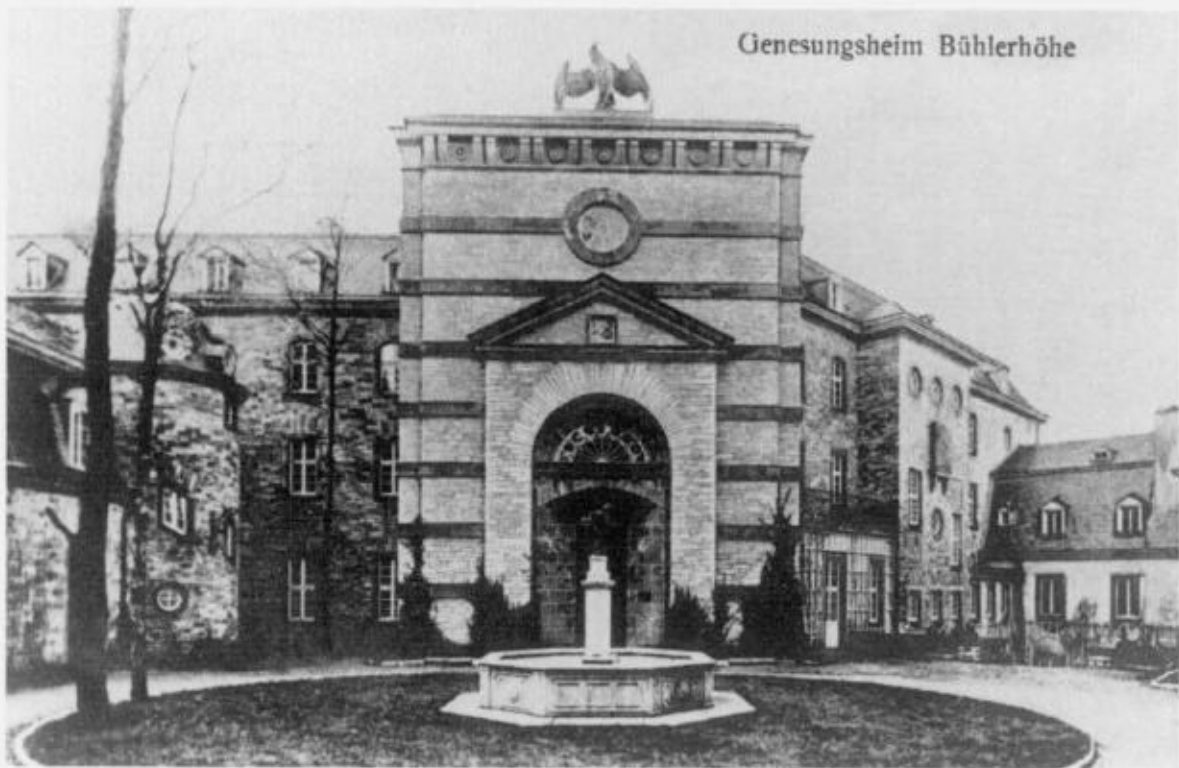
Schlossfassade Bühlerhöhes vom Innenhof aus gesehen. Das Foto entstand bald nach der Fertigstellung 1914
