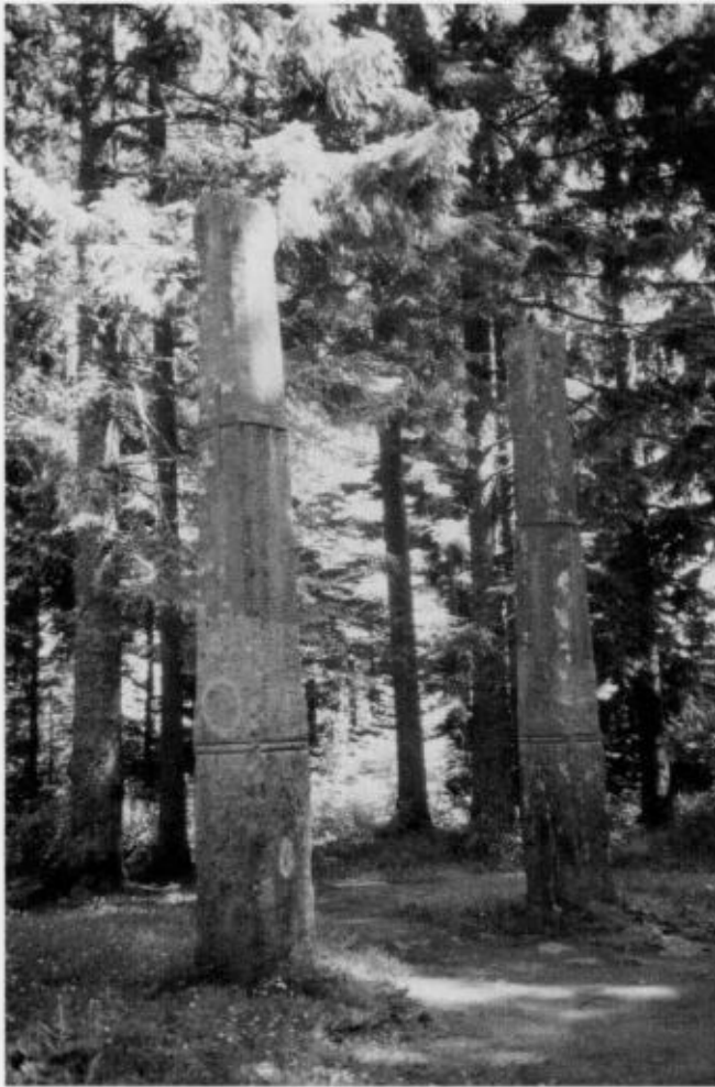
Galgen bei Triberg, 1721 errichtet – Foto Kaufmann
