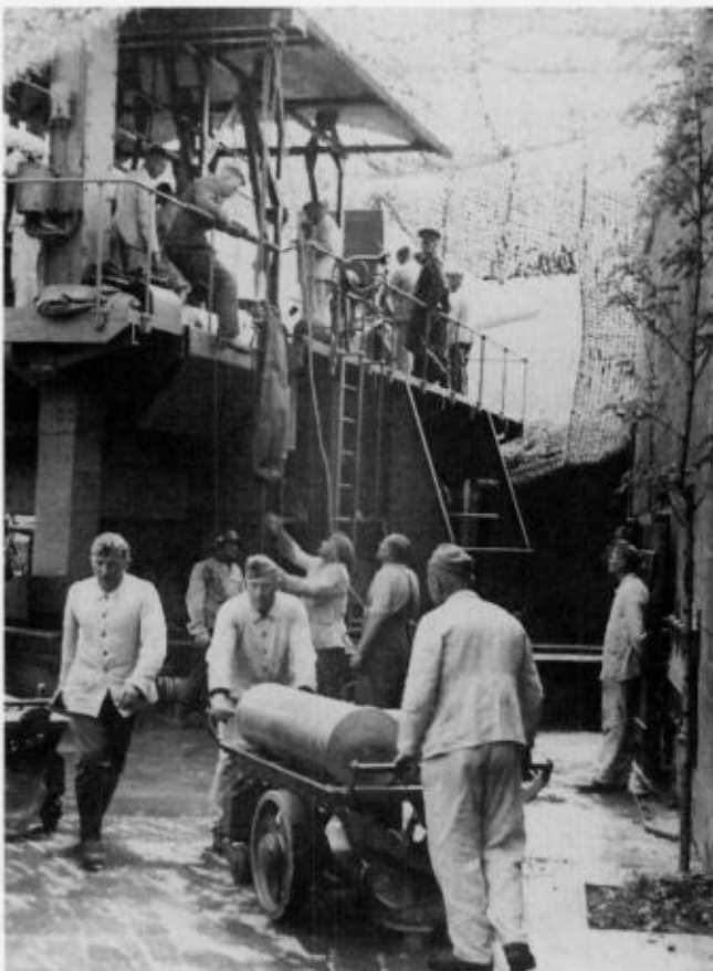
Transport von Kartusche und Geschoss vom Munitionsbunker zum Aufzug bei der Geschütz- anlage Abb.: Käshammer
