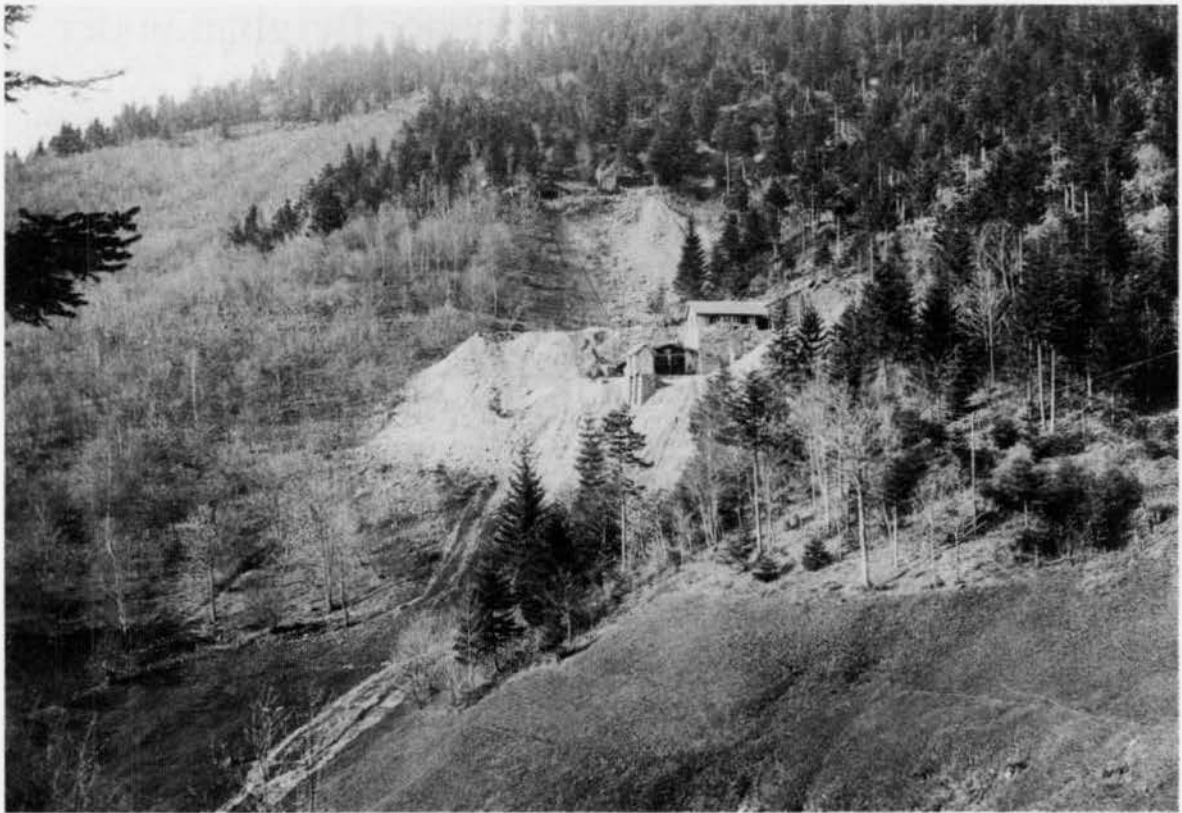
Abb. 1: Stollenmundloch 3. und 4. Sohle mit Bremsberg (1907)
