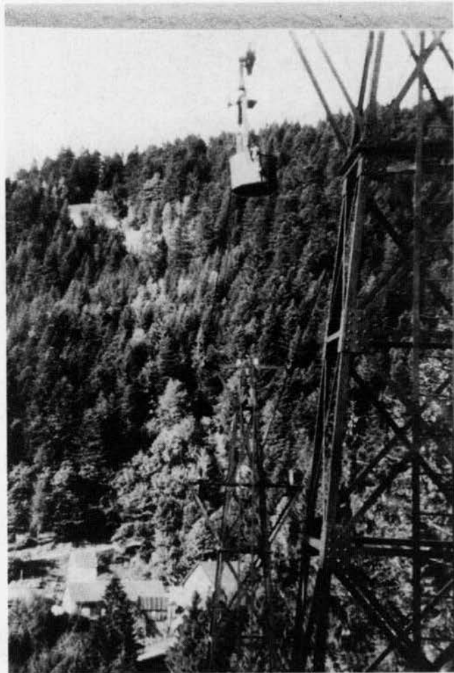
Abb. 2: Seilbahn mit Verladung und Tagesbruch
