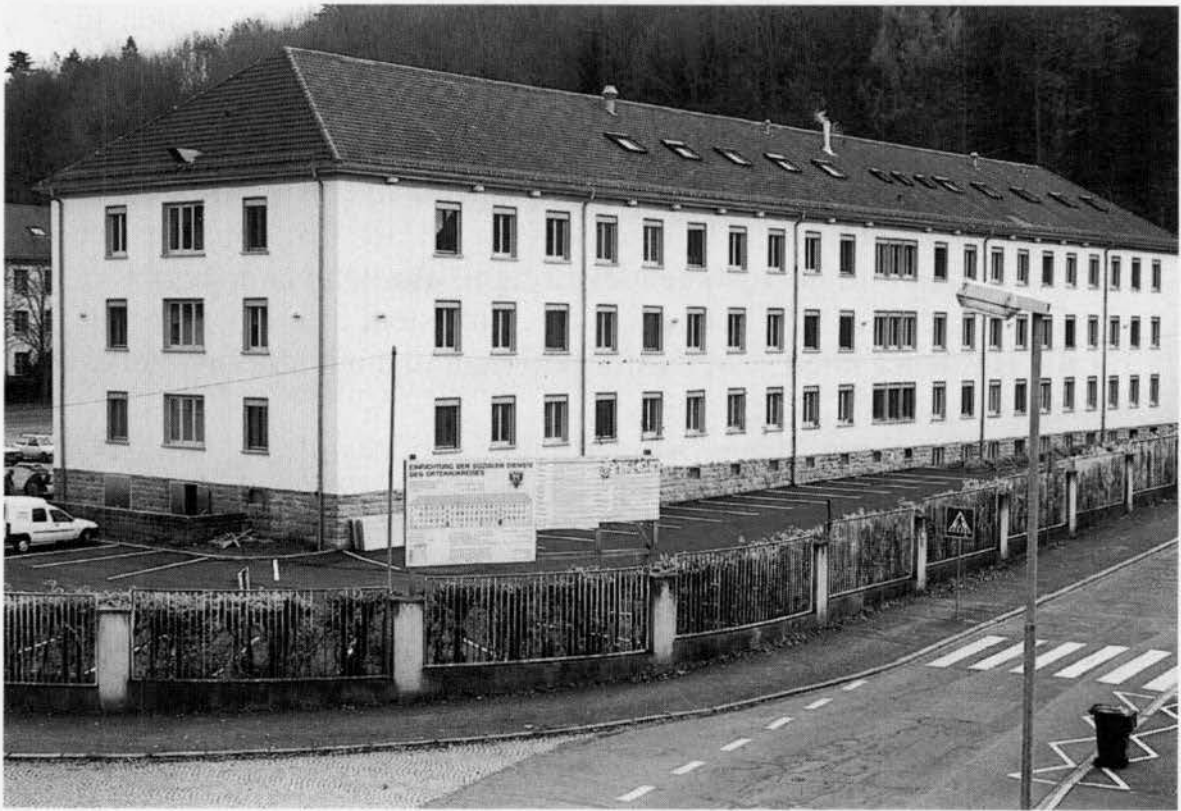
Außenstellen-Gebäude in Lahr, Langemarckstraße 11
