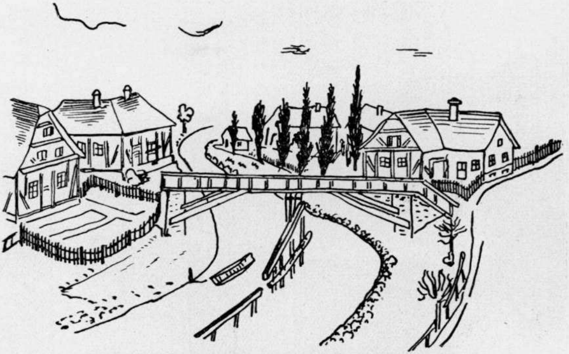
Holzbrücke mit Eisbrecher bei Neumühl 1854.
