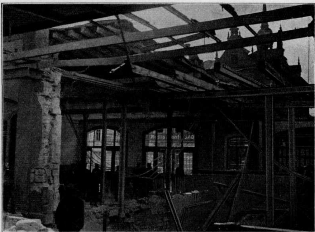
Bombeneinschlag in die Gepäckhalle am Personenbahnhof in Offenburg am 22. Juli 1918.
