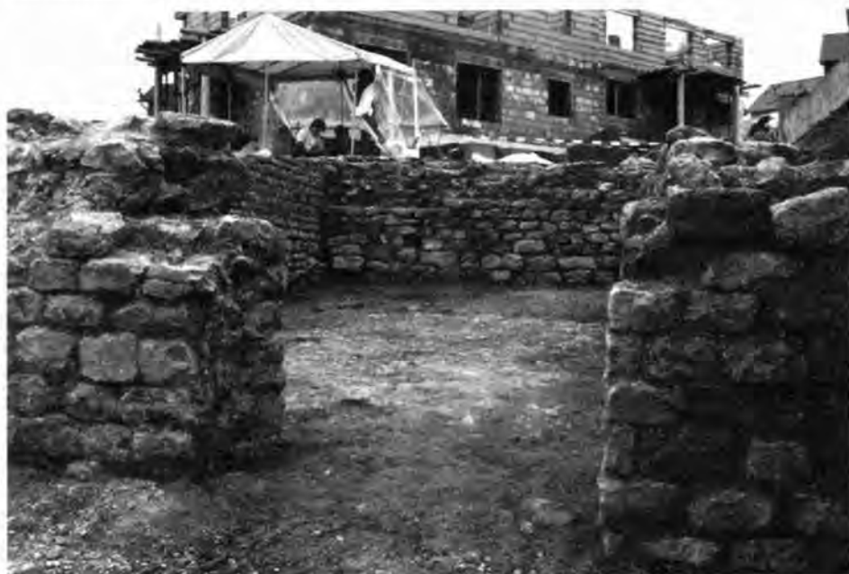
Abb. 4: Überauchen. Blick von Süden in den Keller im südlichen Portikusbereich.
