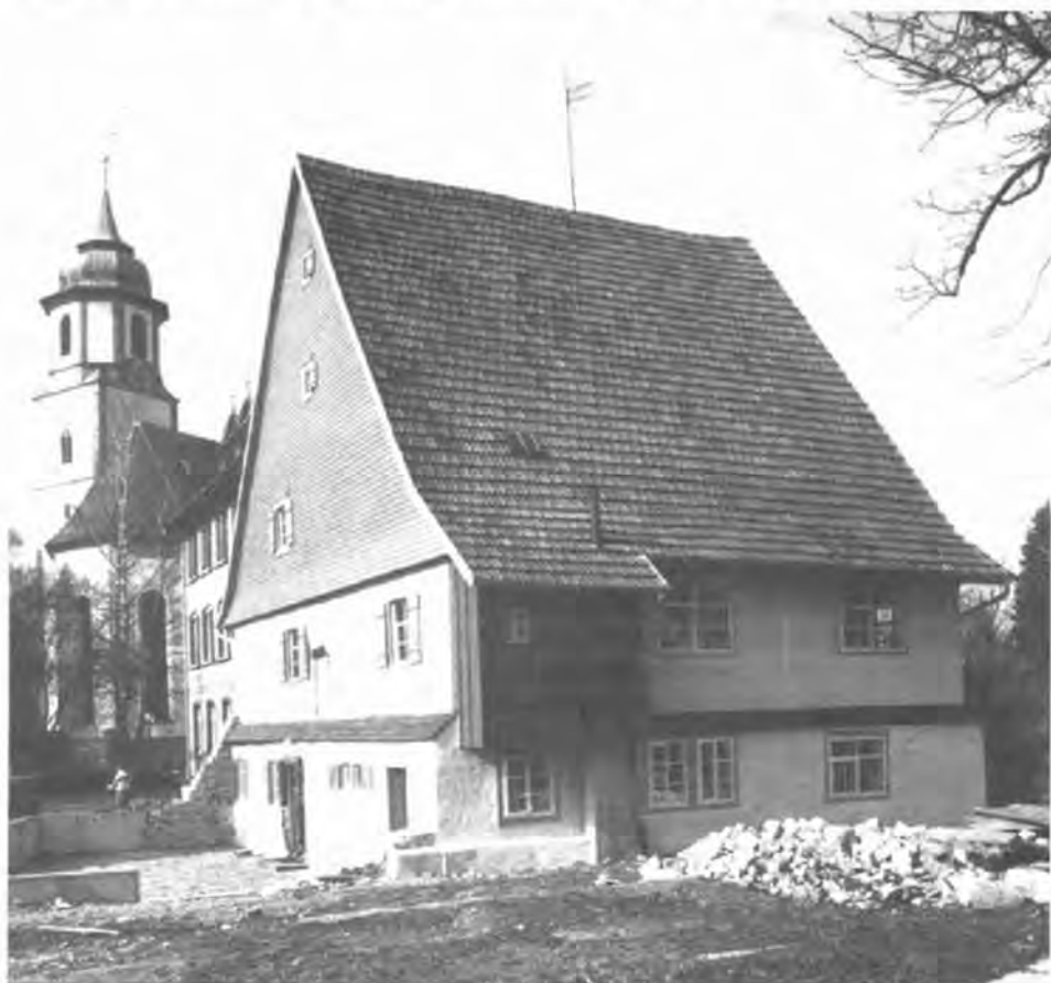
Abb. 8: Ansicht von Nordosten mit neugestalteter Ostfassade und der Nordfassade mit freihängendem Aborthäuschen
