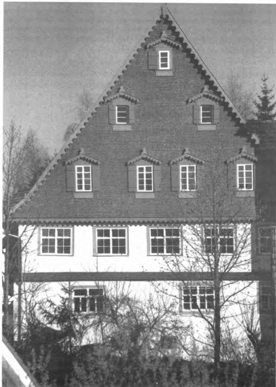
Abb. 7: Westgiebel (Form von 1893) des restaurierten Alten Rat- und Schulhauses.
