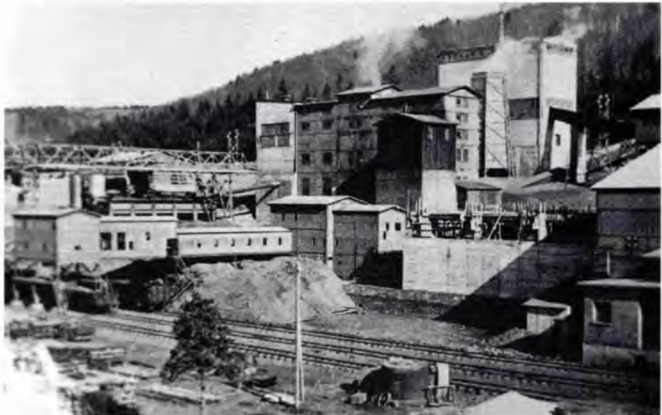
Abb. 6: Die Entscheidung für die Lurgi-Aufbereitungsanlage verzögerte sich bis Anfang 1937, in Betrieb ging sie erst Anfang 1938. Im Bildvordergrund der Erzverladebahnhof, im Hintergrund die Betriebsgebäude des Lurgi-Drehhofens, der aus technischen Gründen schräg, also am Berghang gebaut werden mußte.
