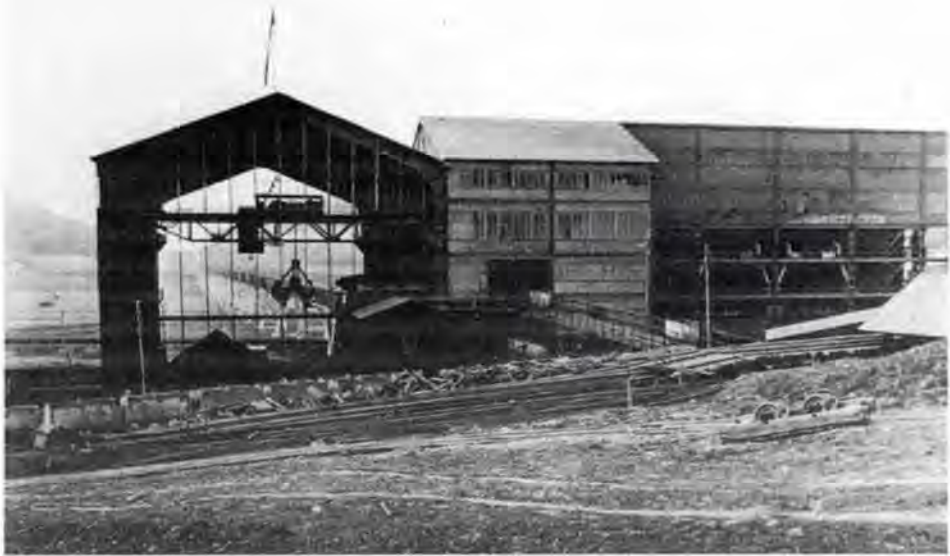
Abb. 3: Erst nach langen Auseinandersetzungen fiel im September 1936 die Entscheidung für ihren Bau. Von links: Roherzstapelhalle (42 m lang, 23 m breit, 25 m hoch) mit 12,5 t - Greiferlaufkran, Maschinenhaus für die Erzförderbahn (25 m x 16 m x 20 m) und das Gebäude für die vier Röstöfen. Durch die Öffnung der Roherzstapelhalle hindurch sieht man Pfeiler und Stahloberbau der Seilförderbahn zu den Stolleneingängen.
