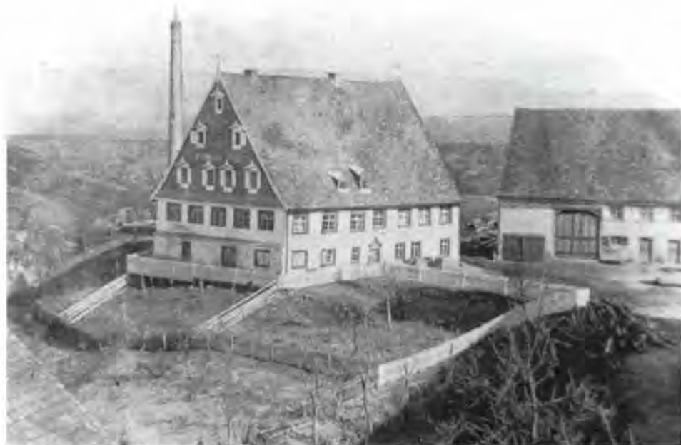
Abb. 6: Das Gebäude um 1890 (Archiv K.M. RUFF, Trossingen).
