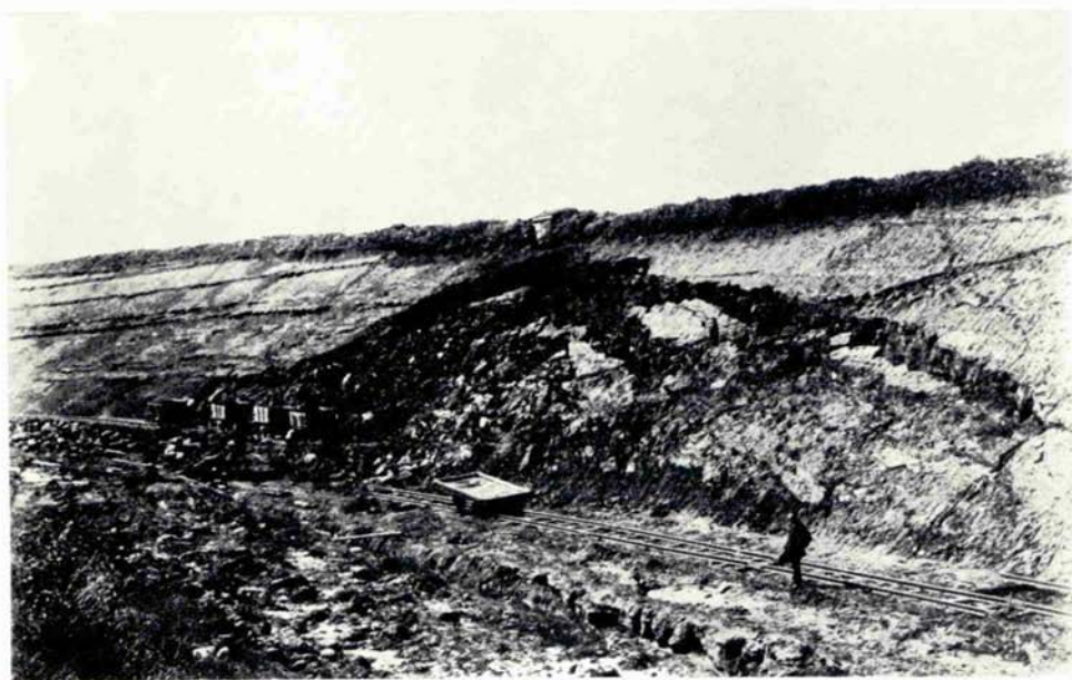
Rutschung in einem Einschnitt
