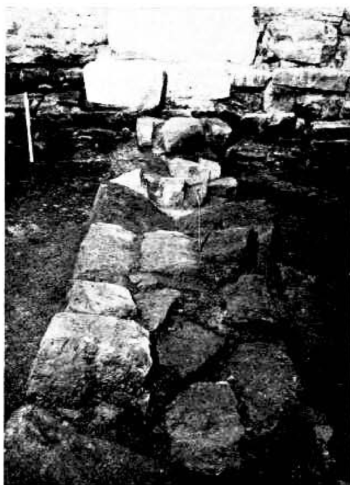
Abb. 2 Fundament der Westmauer des Baues I nach Norden.
