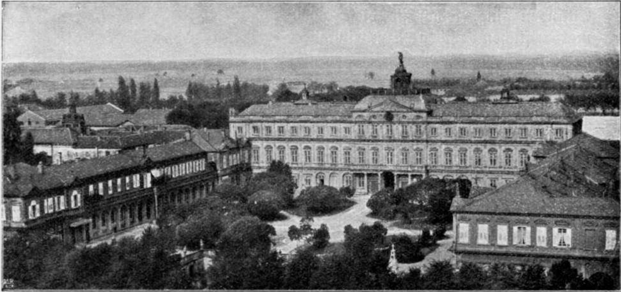
Der durch Anpflanzungen entstellte Ehrenhof der Rastatter Residenz.
