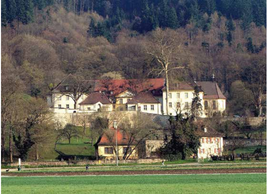
Abb. 5 Die Hoffnung der Stadtverwaltung, „geistig gebrechliche Alte“ in der umgebauten Kartaus unterzubringen, zerschlug sich: Das 1969 eröffnete Heim nahm nur körperlich pflegebedürftige Ältere auf. Aufnahme von 2011 (Foto: Frank Löbbecke).
