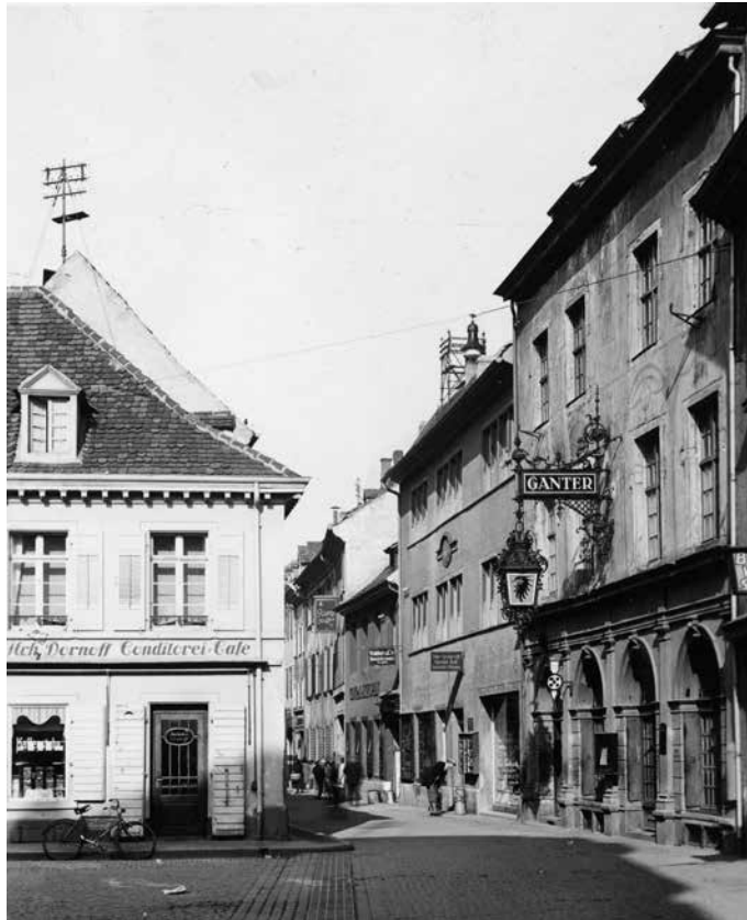
Abb. 1 Schiffstraße 9 in Freiburg (zweites Gebäude rechts), Sitz der Breisgau Loge von 1900 bis 1904, Aufnahme um 1940 (StadtAF, M 7010).
