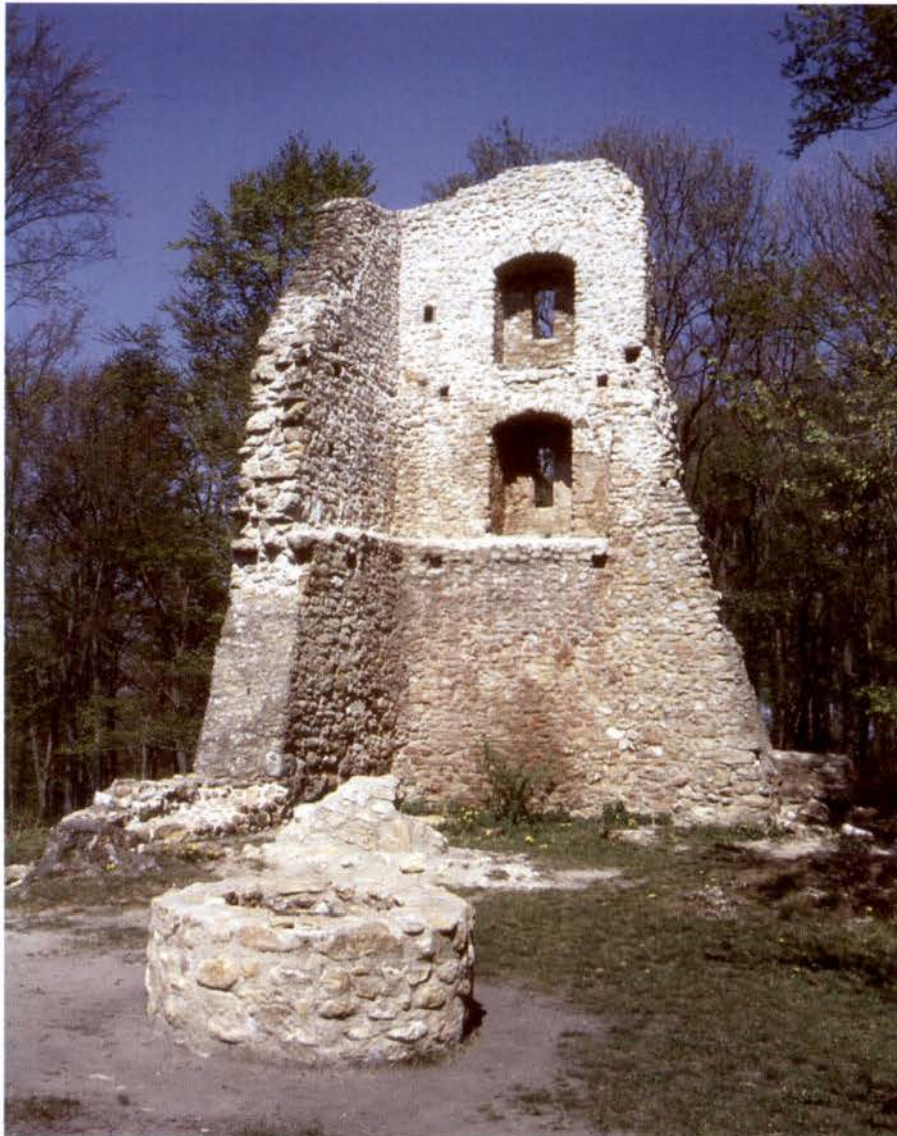
Abb. 12 Nordwestliche Ecke der Schneeburg; im Vordergrund der rezent aufgemauerte Brunnen (Foto: Heiko Wagner 2003).
