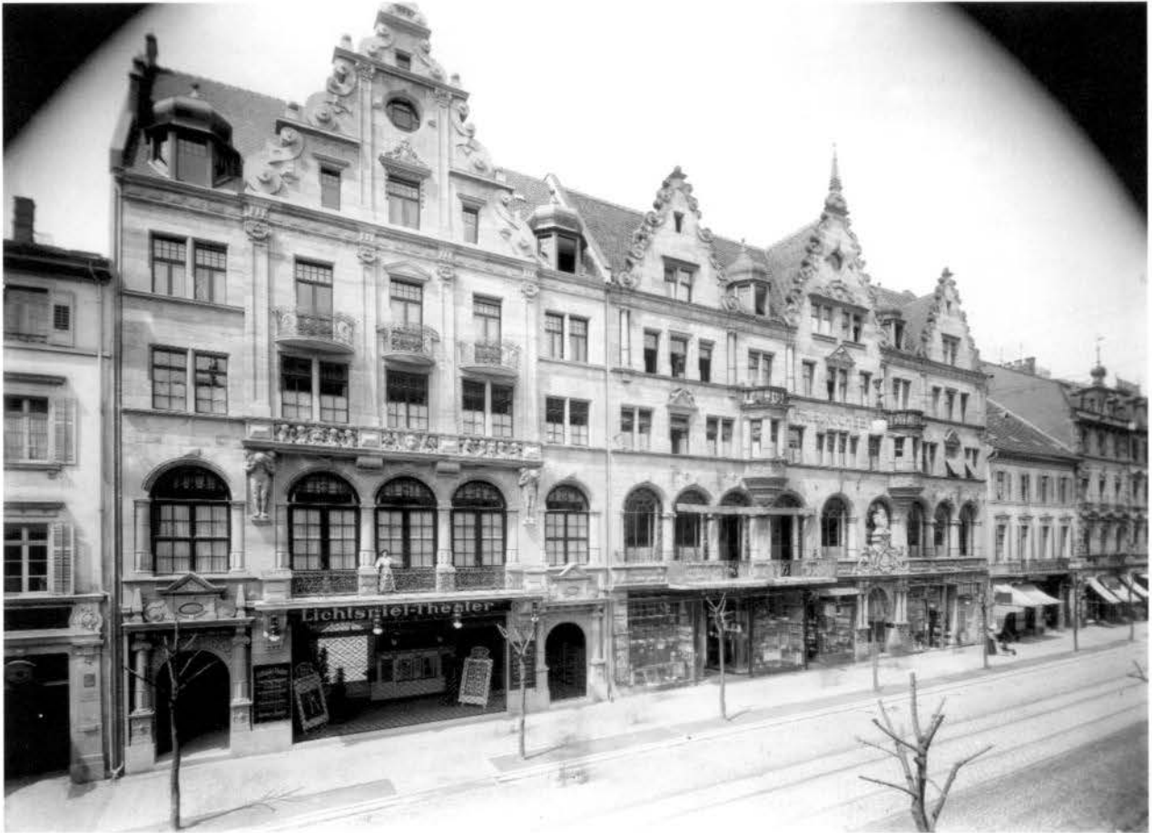
Abb. 1 Friedrichsbau, Ansicht von 1911 (StadtAF, M 737/6028).
