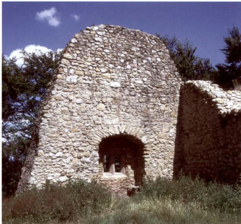
Abb. 11 Ostseite der Schneeburg, innen. Hofbereich mit fälschlich rekonstruierter Sitznische in der Ringmauer. Rechts die Nordwand des südlichen Gebäudes (Foto: Heiko Wagner 2003).
