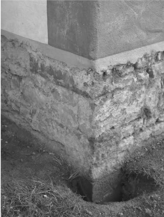
Abb. 5 Riegel, Michaelskapelle. Freigelegter Eckverband an der Nordostecke des Langhauses (Foto: King).
