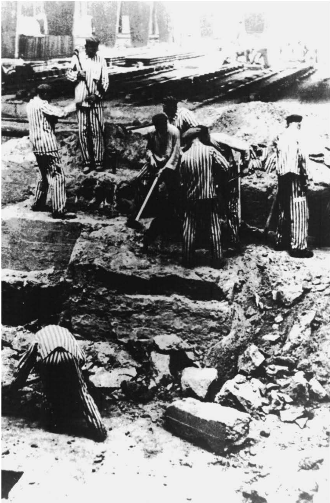
Abb. 7 Tschechische Häftlinge beim Umbau der „Großen Halle“ im Außenlager Klinkerwerk des KZ Sachsenhausen, um 1939 (Stiftung Brandenburgische Gedenkstätten/Archiv Sachsenhausen).
