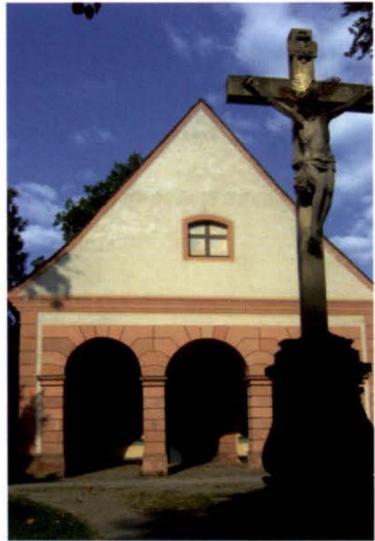
Abb. 7 Heutige Ansicht der Fassade mit der 1970 rekonstruierten Originalbemalung aus dem 18. Jahrhundert (Aufnahme Faller 2008).
