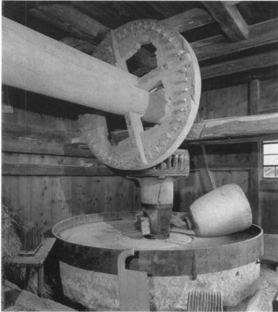
Abb. 5 Die heute im Freilichtmuseum Vogtsbauernhof befindliche Hanfreibe der Oberen Mühle in Steinach (aus: KAUB/SAUER/MAYER [wie Anm. 71], S. 77).
