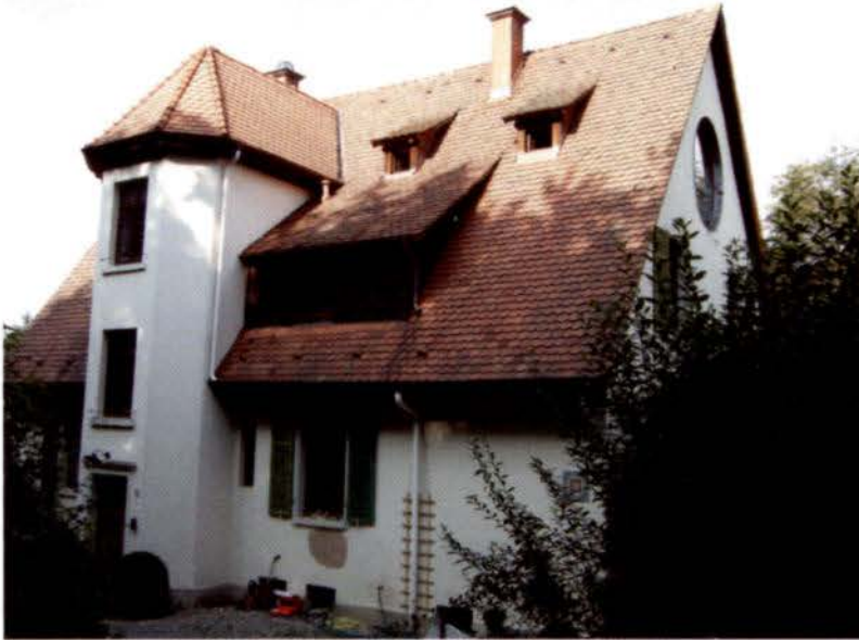
Abb. 2b Haus „Sonnenhalde“, Seitenansicht (Schadek).
