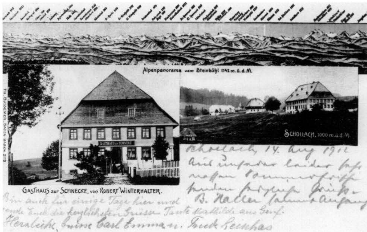
Abb. 1 Das denkmalgeschützte Bauerngasthaus zur Schnecke (Schneckenhof) in Hinterschollach. Die Postkarte von 1912 zeigt den Zustand um 1900 (Nienhaus).
