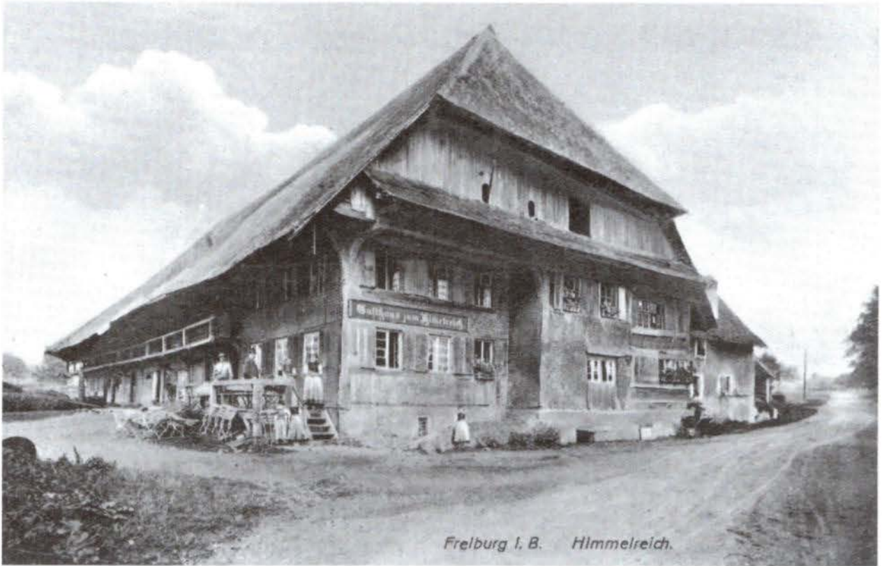
Abb. 1 Das Gasthaus „zum Himmelreich“ am Eingang des Höllentals in Kirchzarten-Burg um 1900. Das kaminlose Dach ist noch vollständig mit Holzschindeln gedeckt (Nienhaus)
