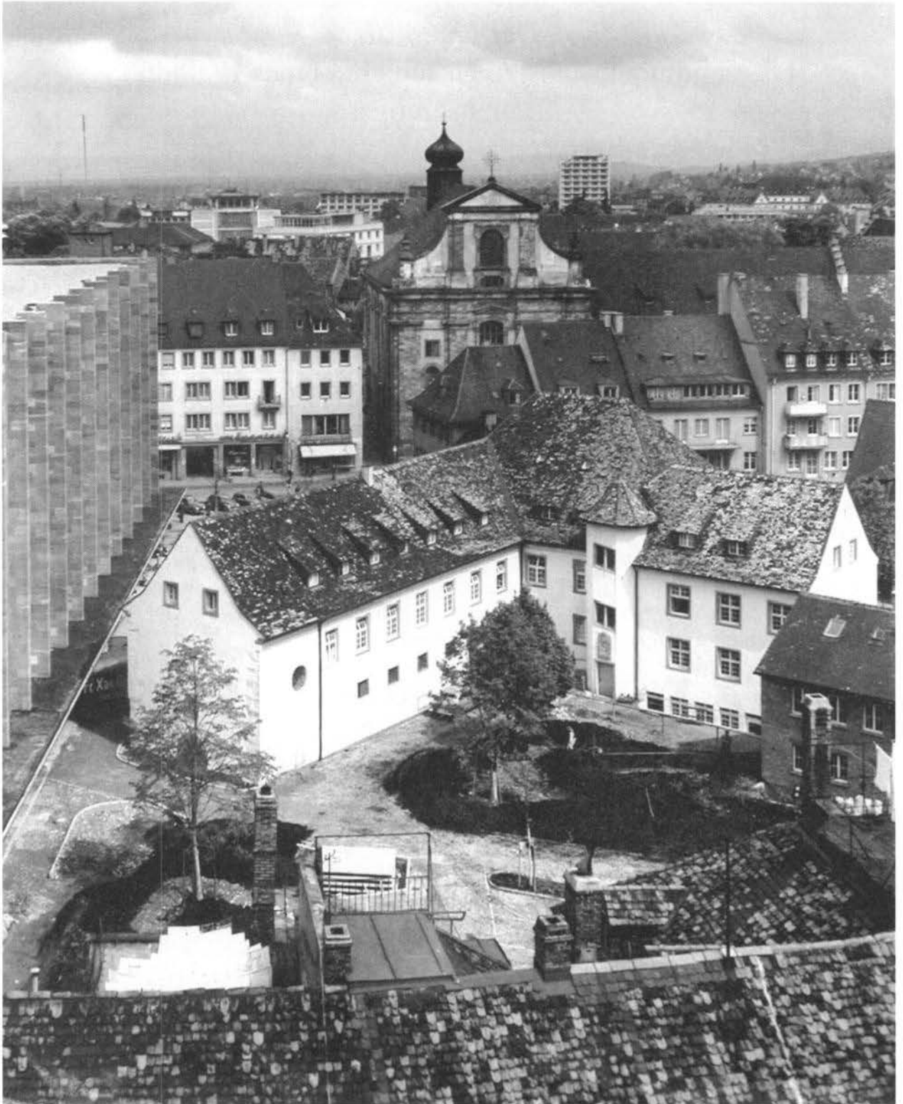
Abb. 1 Peterhof von Süden vor dem Bau des Kollegiengebäudes III im Jahr 1969 (UBA)
