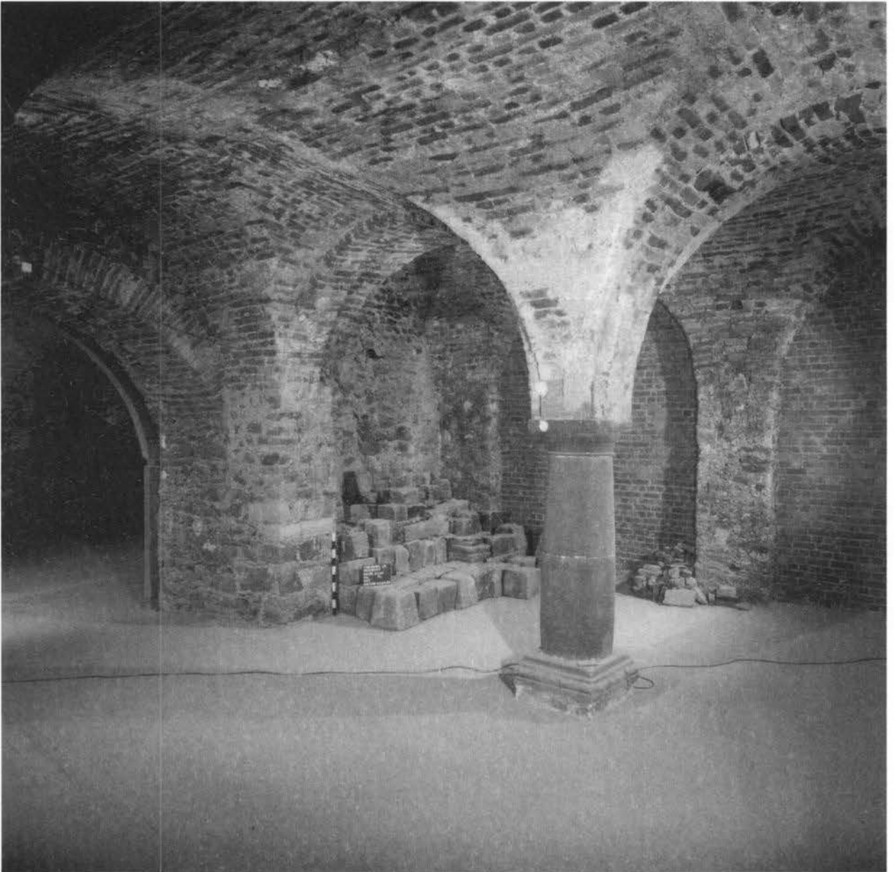
Abb. 6 Mittlerer Vorderhauskeller, erkennbar ist die Backsteinverblendung von 1957 vor der straßenseitigen Mauer (beide Nischen rechts), mittelalterliche Wackenmauer und darunter Abtiefungsmauerwerk (Mittelgrund) sowie der Durchgang zum gewölbten Nordwest-Keller (LDA, Außenstelle Freiburg, Bildarchiv)
