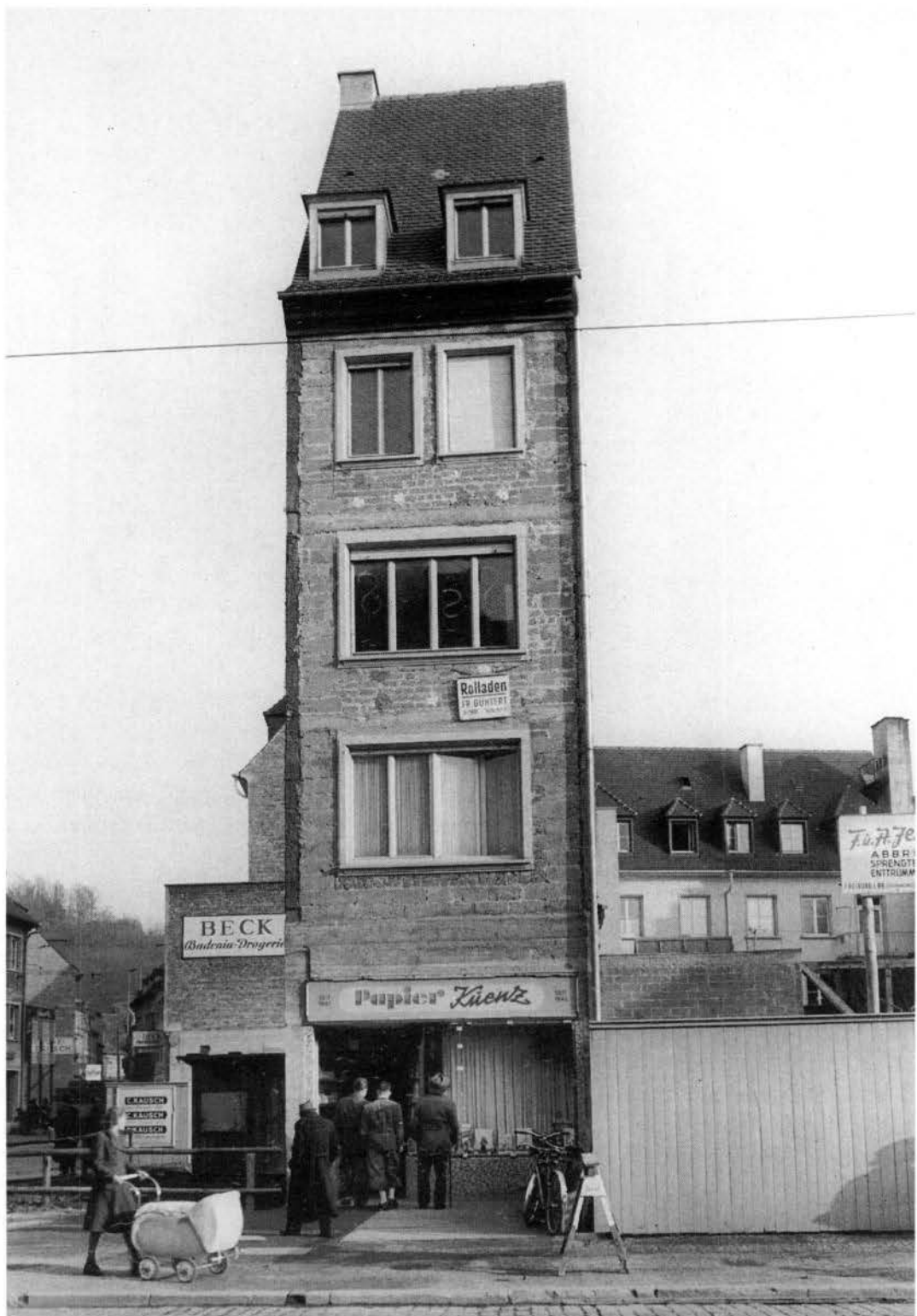
Abb. 7 Vor der Währungsreform waren schon 80 Prozent der leicht beschädigten und ein Drittel der schwer beschädigten Wohnungen in Freiburg wieder in Stand gesetzt worden. Der Wiederaufbau erhielt jedoch erst nach der Währungsumstellung Auftrieb. Hier eines der ersten neuen Geschäftshäuser, das sogenannte Handtuchhaus mit knapp drei Metern Breite in der Kaiserstraße 207, bei dem nach dem alten, bereits im Mittelalter verwendeten Grundriss wieder aufgebaut wurde. (Stadtarchiv Freiburg, Photo Leif Geiges)
