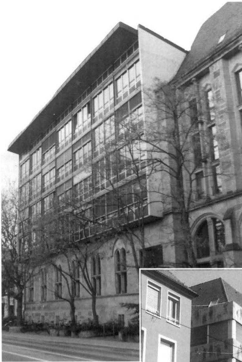
Abb. 9 Nicht unumstritten war der Verzicht auf den Wiederaufbau des zerstörten Südflügels der Alten Universitätsbibliothek (Photo des Autors)
