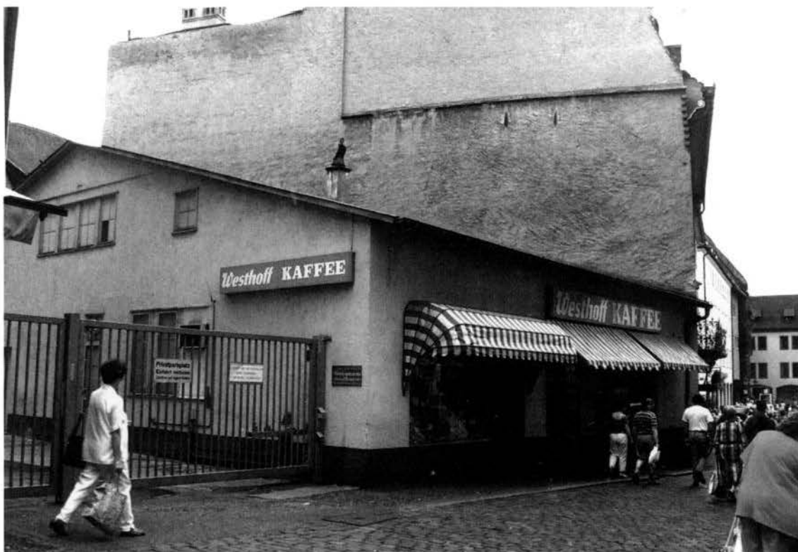
Abb. 7 Laden der Firma Westhoff in einem ehemaligen Behelfsbau der Nachkriegszeit an der Eisenstraße (Photo des Autors)
