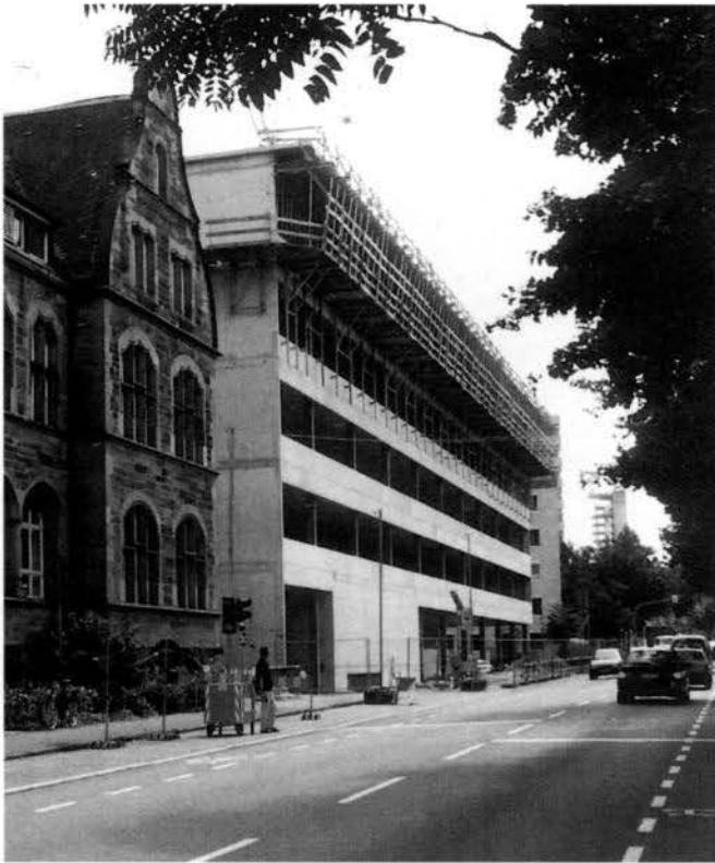
Abb. 11 Neubau des Pharmakologischen Instituts an der Stefan-Meier-Straße (Photo des Autors)
