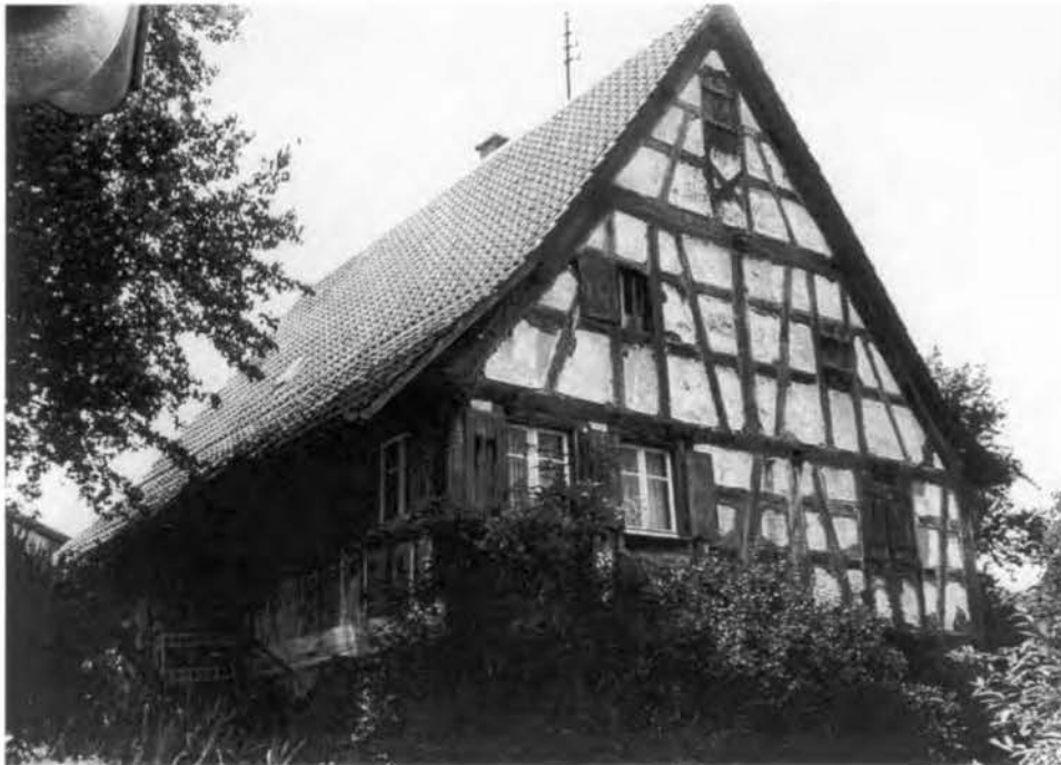
Abb. 2 Giebelwand des Klosterhofs vor der Restaurierung. (Bildvorlage der Autorin)
