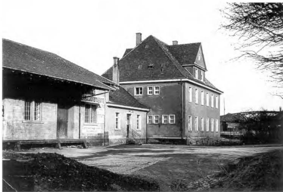
Abb. 3 Die inzwischen abgerissene Eilguthalle der Reichsbahn an der Snewlinstraße ca. 1930. (StadtAF, M 70 S Plan Nr. 201/26 Aufnahme 37)
