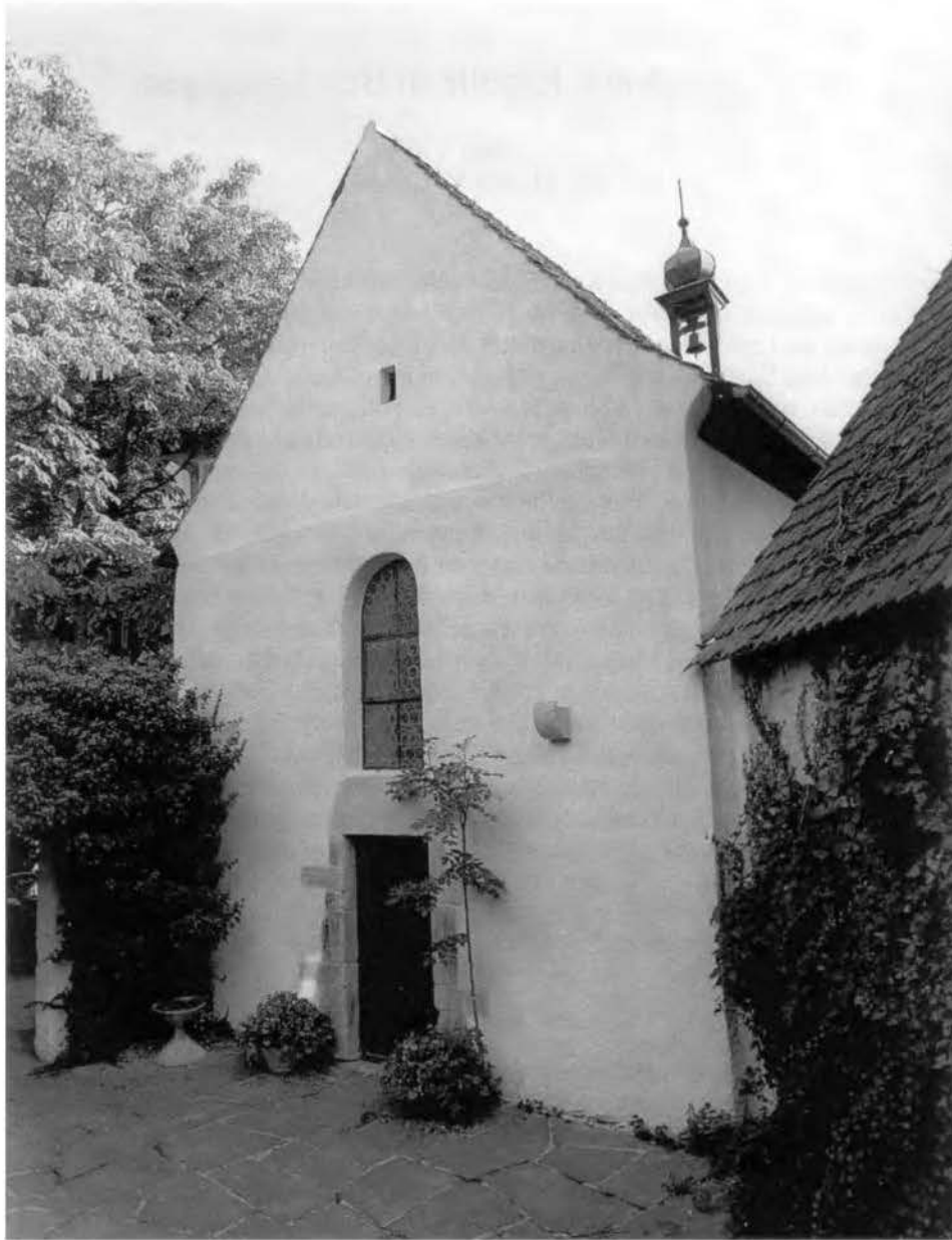
Abb. 1 Ansicht der Glöcklehof Kapelle von Südwesten nach der Neuverputzung 1993. (Photo J. Jeras, Gündlingen)
