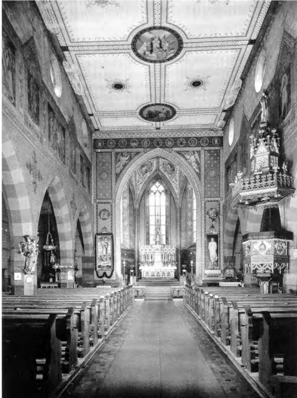
Abb. 5 Pfarrkirche St. Martin, Staufen. Die historische Aufnahme zeigt die ab 1485 errichtete Pfarrkirche in einer Raumfassung des 19. Jahrhunderts, die die originale gotische Bausubstanz kaum noch erahnen läßt. (Bild und Filmstelle der Erzdiözese Freiburg)
