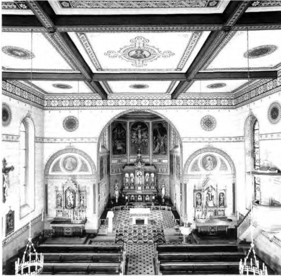
Abb. 12 Pfarrkirche St. Hilarius, Bollschweil, errichtet ab 1839 (Benediktion 1844), Architekt Johann Friedrich Voß. Ausmalung durch Anselm Endres und Joseph Schultis, Altarausstattung Franz Josef und Karl Simmler. Die gesamte einheitliche Ausstattung und Dekoration ist geschlossen erhalten geblieben. (Bild und Filmstelle der Erzdiözese Freiburg)
