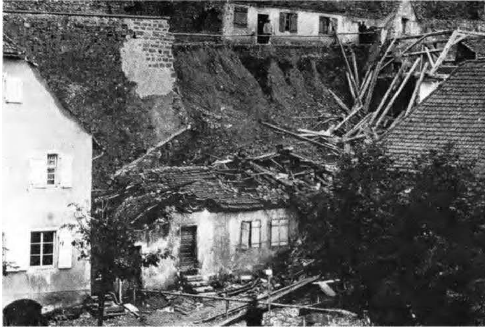
Abb. 9 Einsturz des Langen Wegs 1897. (Klein, wie Anm. 94, Abb. 51)
