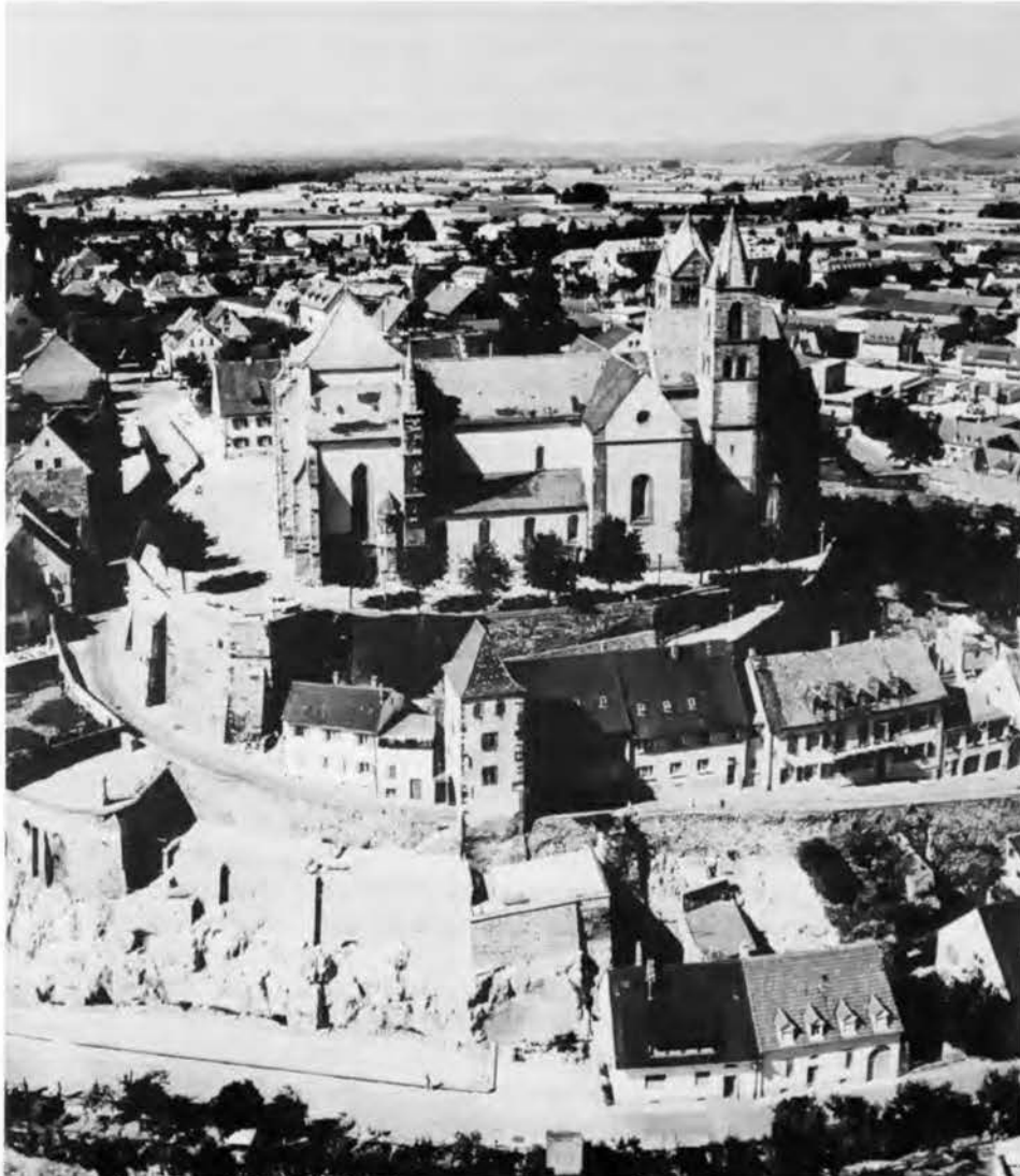
Abb. 10 Breisacher Münsterberg mit Wintersbrücke und Hagenbachturm von Süden. Die Michaelskapelle mit Kärner lag dort, wo ein Auto parkt. Zu beachten sind die hohen Stützmauern, an deren Fuß die zum Münsterchor führenden Kilchstaffeln. Die Schänzletreppe (Kilchweg, vgl. Abb. 3) liegt unerkenntlich östlich vom Kirchenchor. (Landesbildstelle Rheinland Pfalz)
