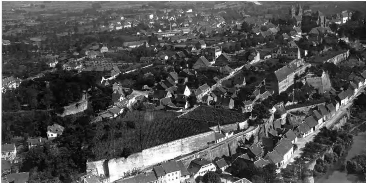
Abb. 8 Luftaufnahme der Oberstadt von Nordwesten, etwa 1935. Im Vordergrund die gewaltigen Stützmauern, die für die Anlage des davor erkennbaren Langen Wegs erforderlich waren; dahinter links das Burggelände mit Tullaturm. (Strähle KG, Schorndorf, Luftbild 2665)
