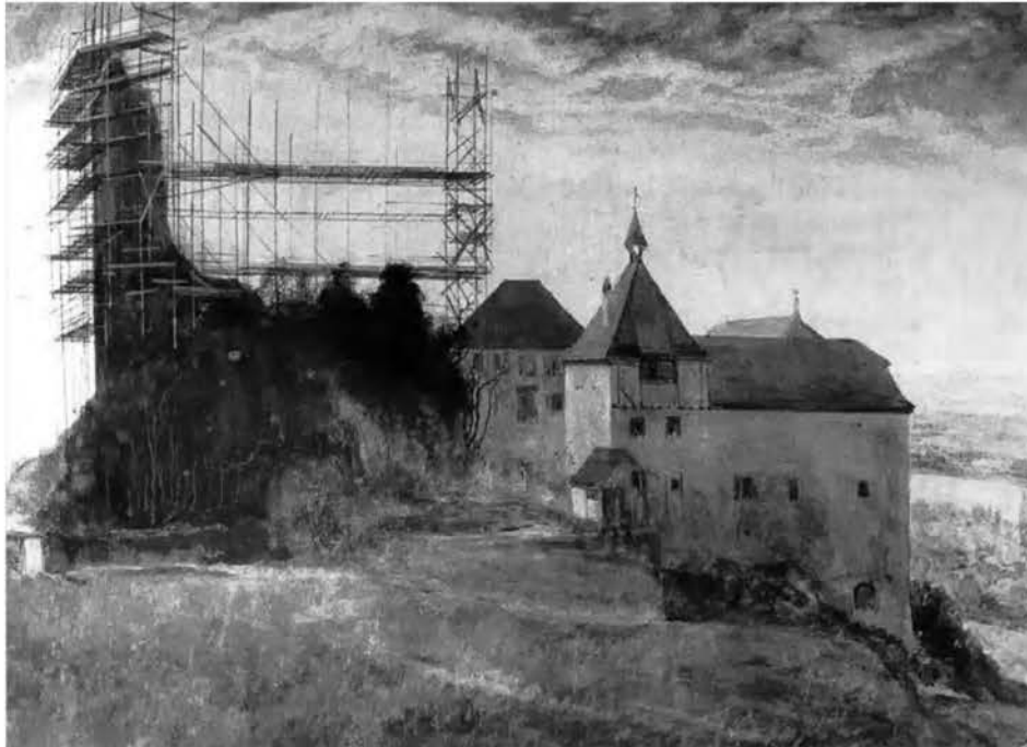
Abb. 3 Das erste Stadium des Auf- und Ausbaus des Turms der Burgruine Sponeck am Rhein. Bauherr war Hans Adolf Bühler, von dessen Hand dieses Gemälde stammt. Es ist übrigens unvollendet, wie einem Vermerk auf der Rückseite zu entnehmen ist: „Bitte bei nächster Gelegenheit zurückbringen. 1930.“ (Foto: R. Liessem Breinlinger)
