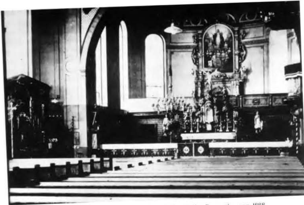
Abb. 10 Inneres der Kirche von Günterstal nach der Renovation von 1888.
