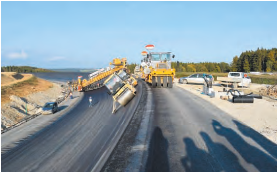
Der sogenannte Brückenfertiger ermöglicht den Bau der zwei überhöhten Kurven des Ovals.
