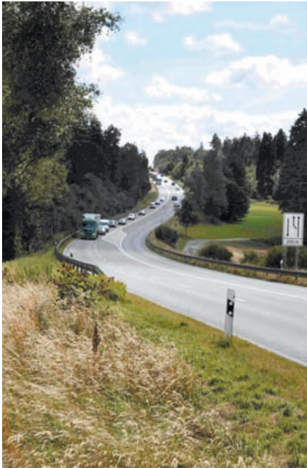
Die B 31 nach dreispurigem Ausbau (2004 / 05).
