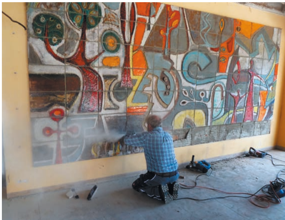
Abbau des Wandreliefs in der Kinderklinik.
