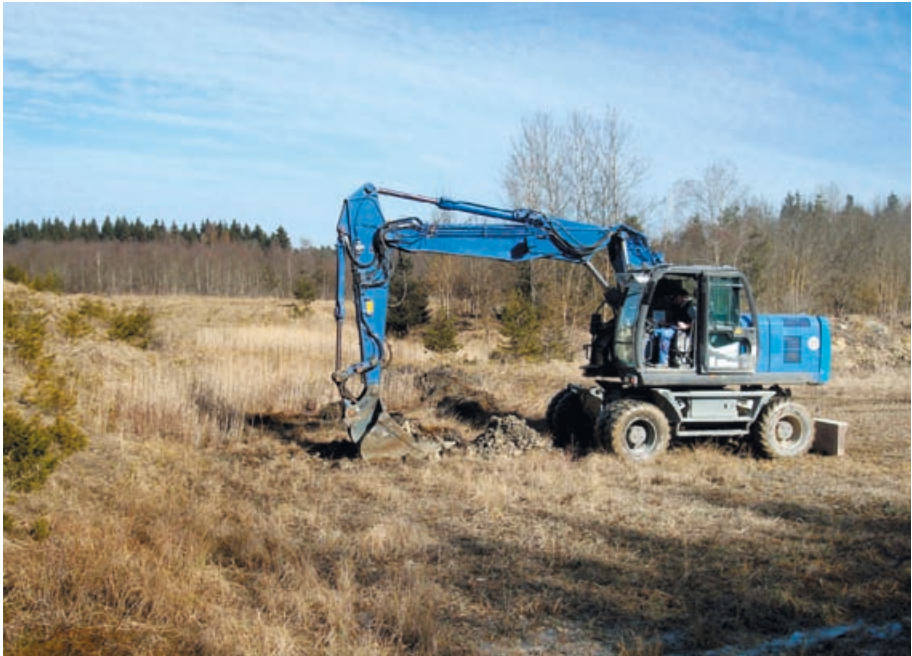
Baggerarbeiten in der ehemaligen Tongrube (März 2015). Foto: Heinz-Jürgen Walter.
