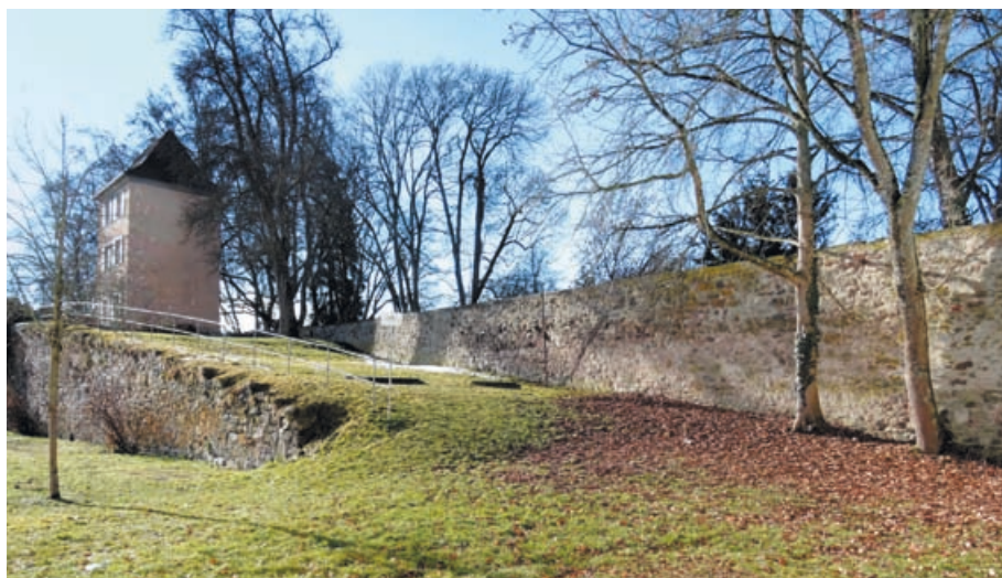
Geschützrampe an der Innenseite der Villingener Stadtmauer im Bereich Franziskanergarten.
