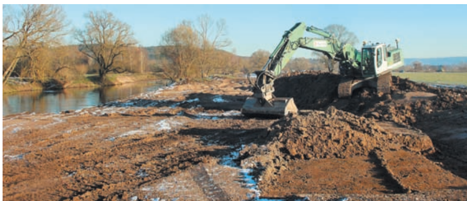
Durch Erdbtragung im Uferbereich entstehen neue Überflutungsflächen.
