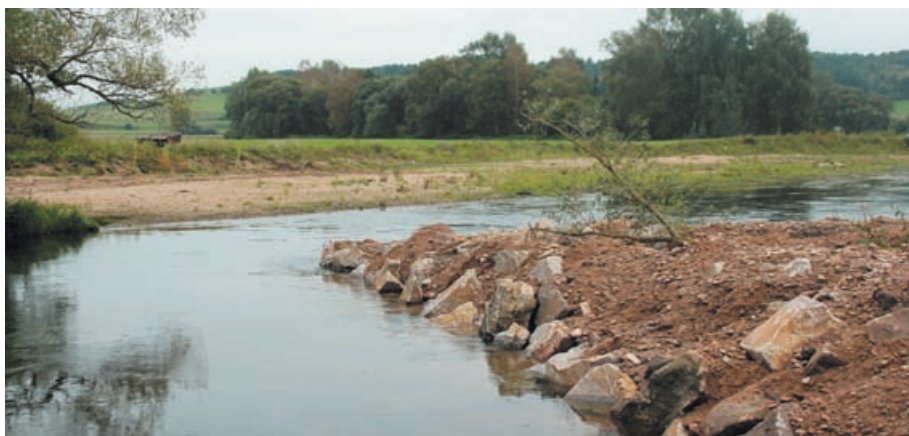
„Störbuhnen“ sollen die Eigendynamik (Abtragung und Anlandung) der Donau erhöhen.
