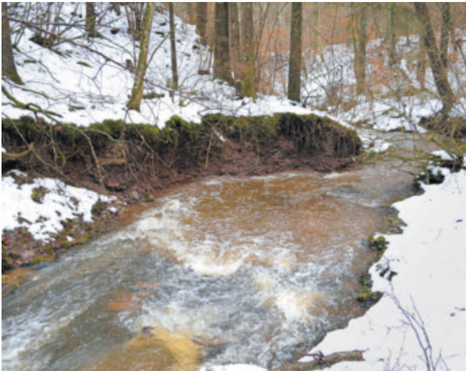
Winterliches Hochwasser des Hofbächles (Januar 2013).
